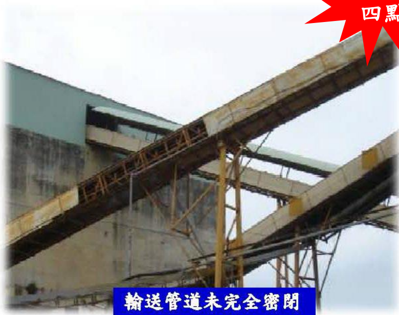
於建築物內輸送，但未符合封閉式建築物之規定
