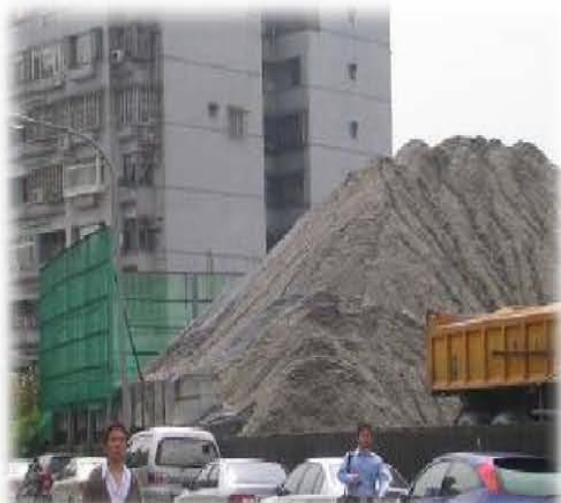
防塵網高度未達設計或實際堆置高度 1.25倍
