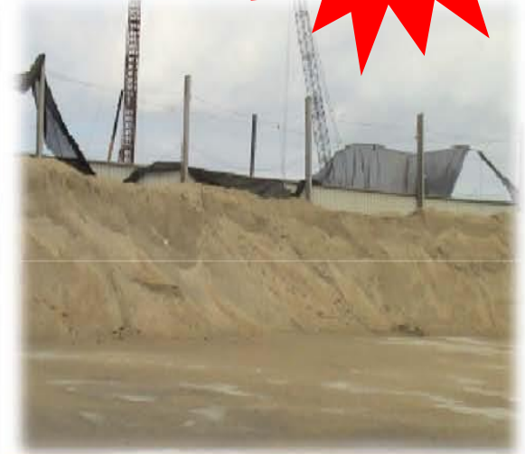
防塵網破損部分達圍封面積10% 以上
