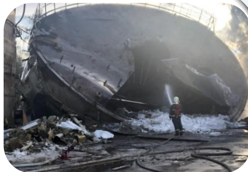
儲槽破損或儲槽物料洩漏引起火災事故
