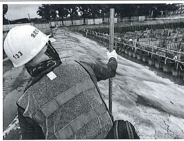
114.7.30 職安設施施工
