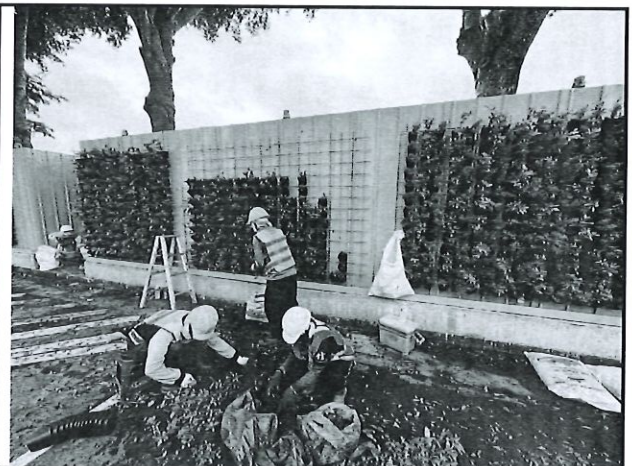
114.7.8 綠圍籬植栽施工
