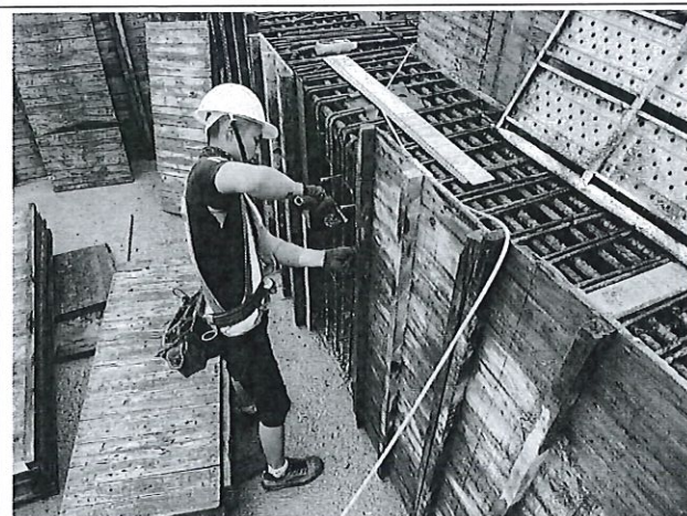
114.7.29 地梁模板組立
