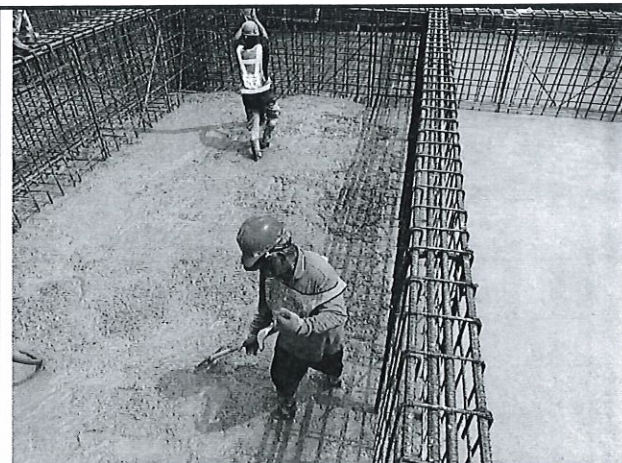
114.7.23 基礎混凝土澆置
