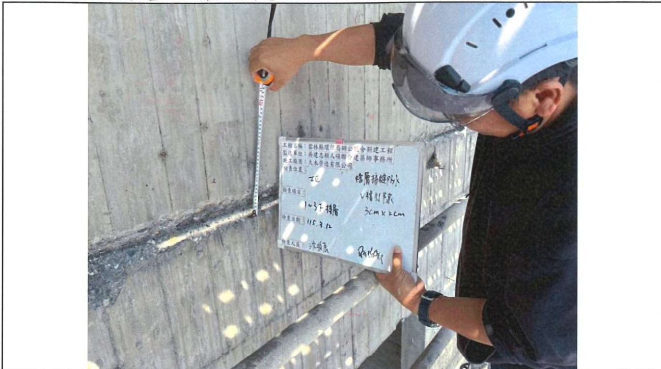
相片說明 115.03.12_1-3F樓層接縫查驗(V槽打除) 1
