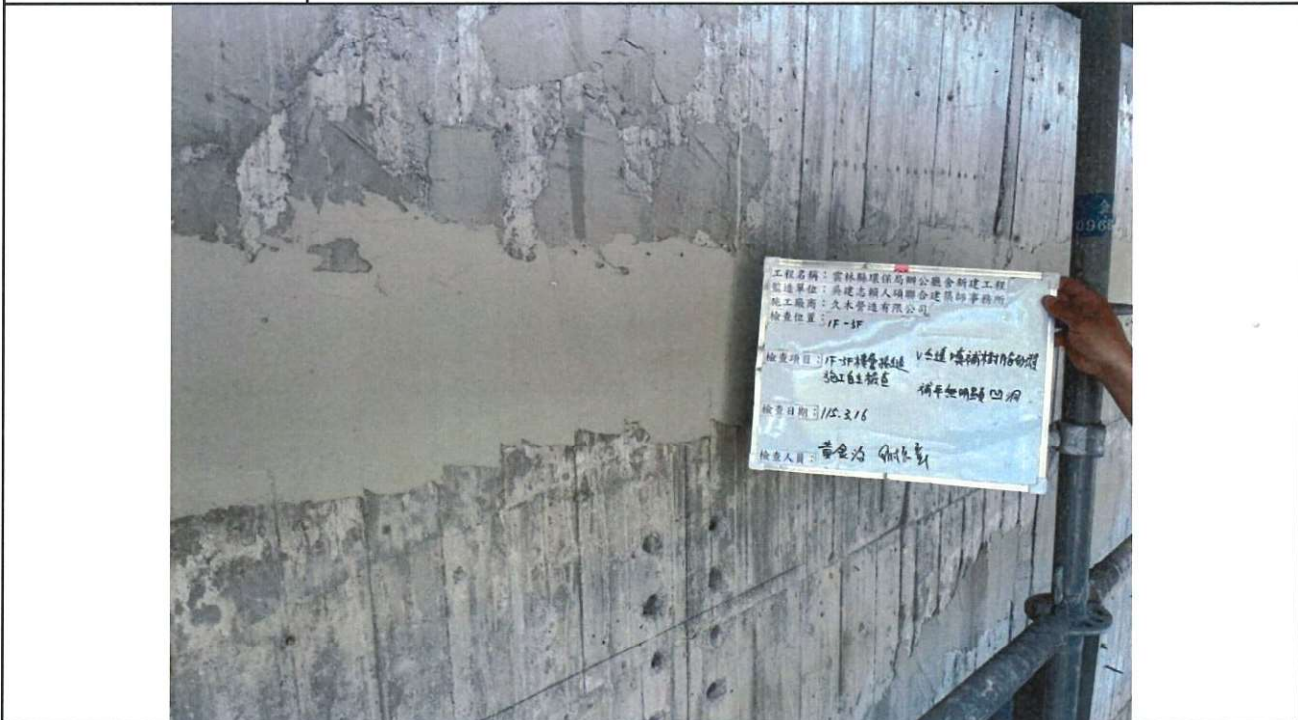
相片說明 115.03.16_1-3F樓層接縫查驗(V縫填補樹脂砂漿) 2
