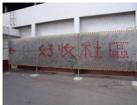
利用回收寶瓶製程隔熱環保牆
