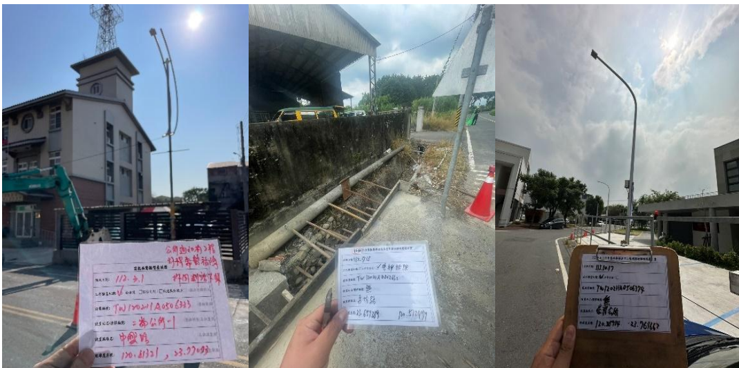
圖3-36 感測器裝設燈桿因長期工程拆除
