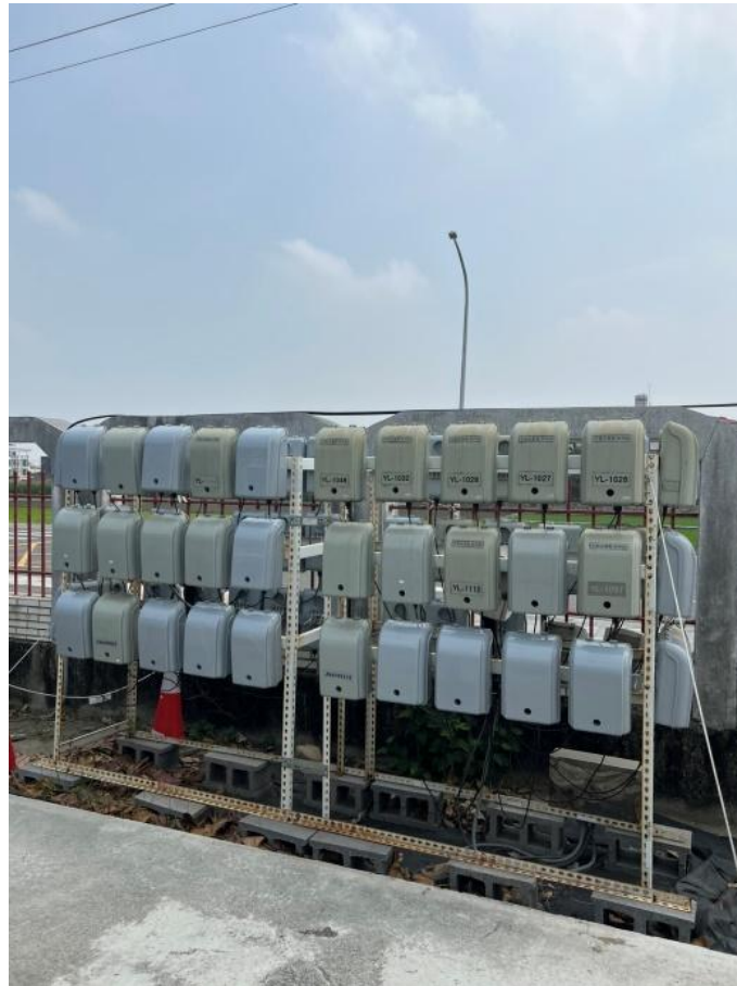
圖4-9 一致性比對現場架設作業
