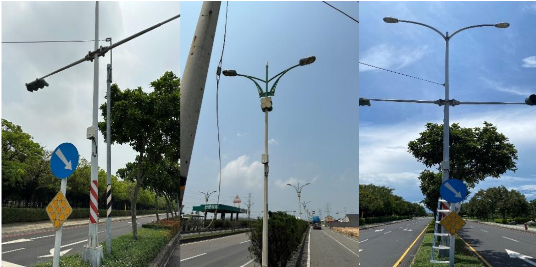
圖3-35 感測器裝設於中央分隔島不易維護
