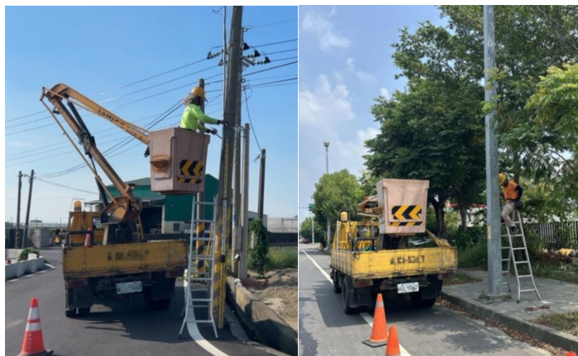
圖4-48 現場施工情形
