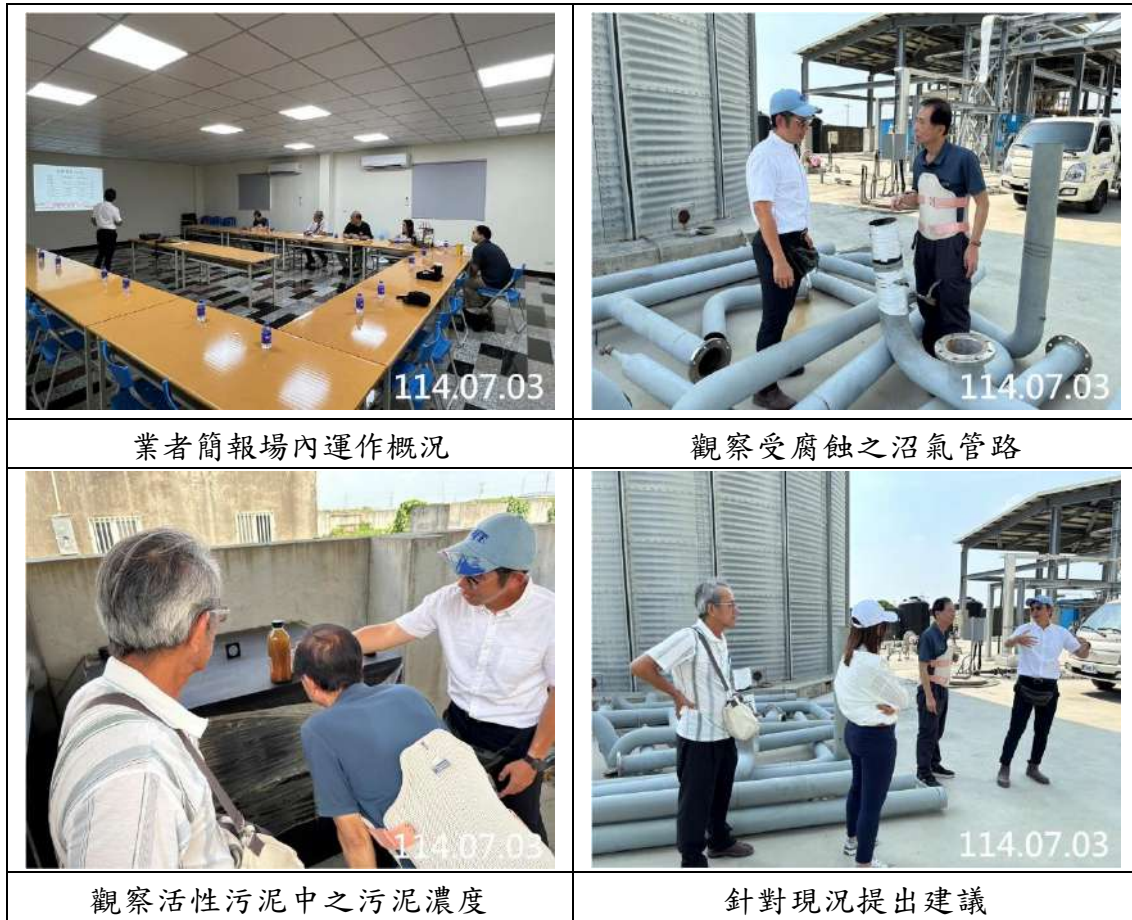
圖 4.5.2-3、綠野能源股份有限公司現地督導作業辦理情形
