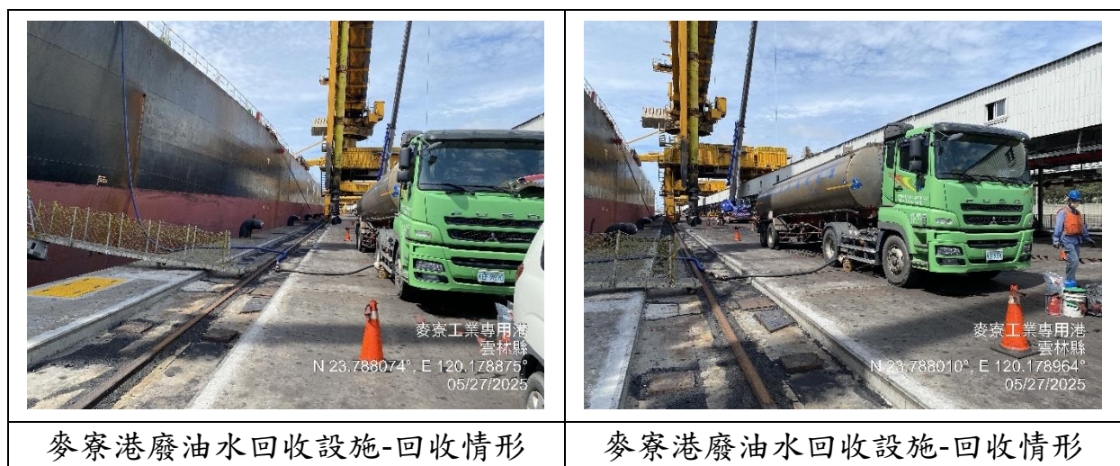
圖 3.2.1-5、麥寮工業港廢油水回收情形(摘錄)
