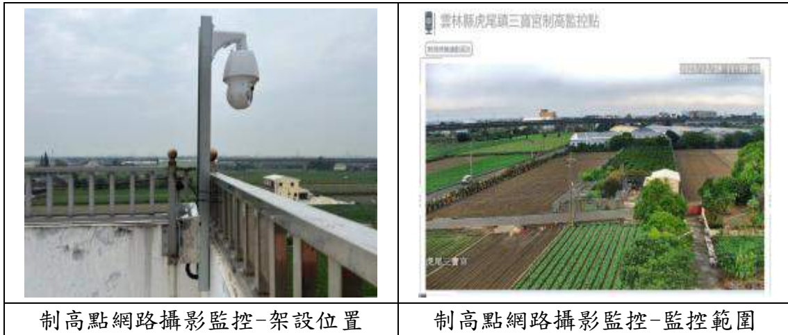
圖 3.4.2-12 AI 煙霧主動通報系統安裝情形(虎尾鎮三寶宮)
