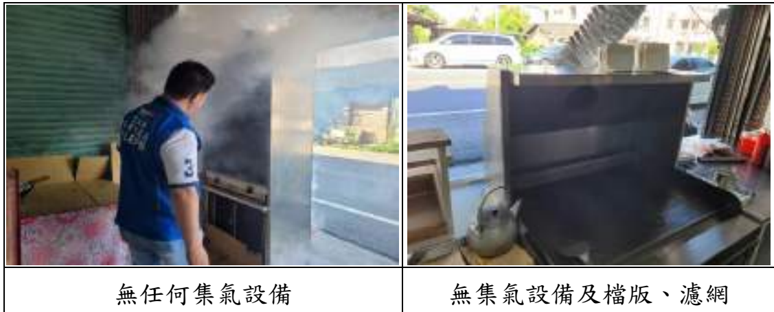
圖 4.1.2-6 查核時前端處理設備未裝設情形
