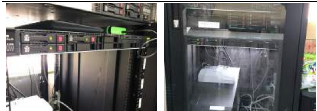
圖 3.2.2-1 機架式伺服器(1U 規格)裝設於雲林環保局
