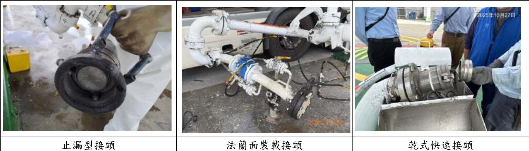
圖 6.2-1、裝載操作設施接頭現場查核圖
