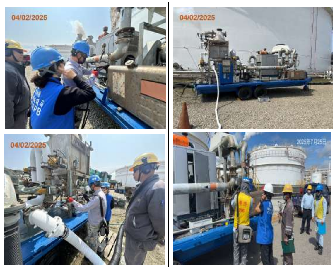
圖 5.3-1、儲槽氣體削減作業現場查核情形
