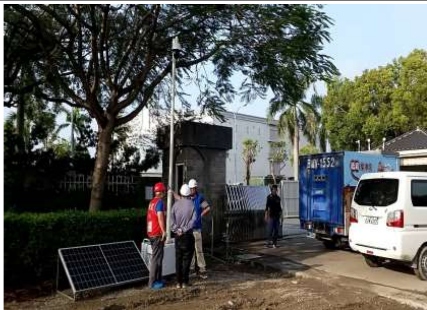
圖 9.4-5 第 5 處營建工地智能環保哨兵設置圖
