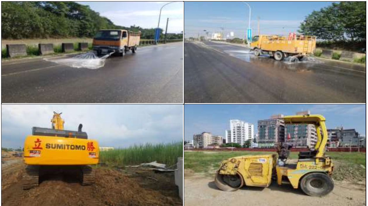
大埔溪中興一號及竹圍堤防改善工程併辦土石標售
