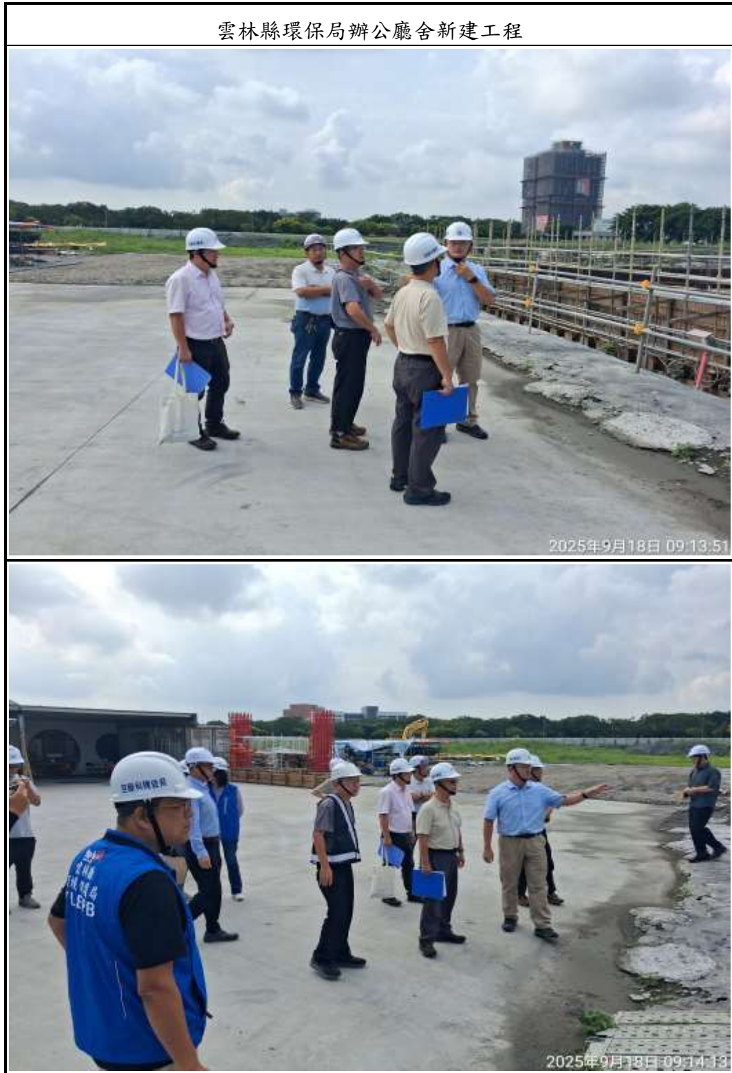
圖 6.5-1 優良營建工地複評現場實況圖(2/3)
