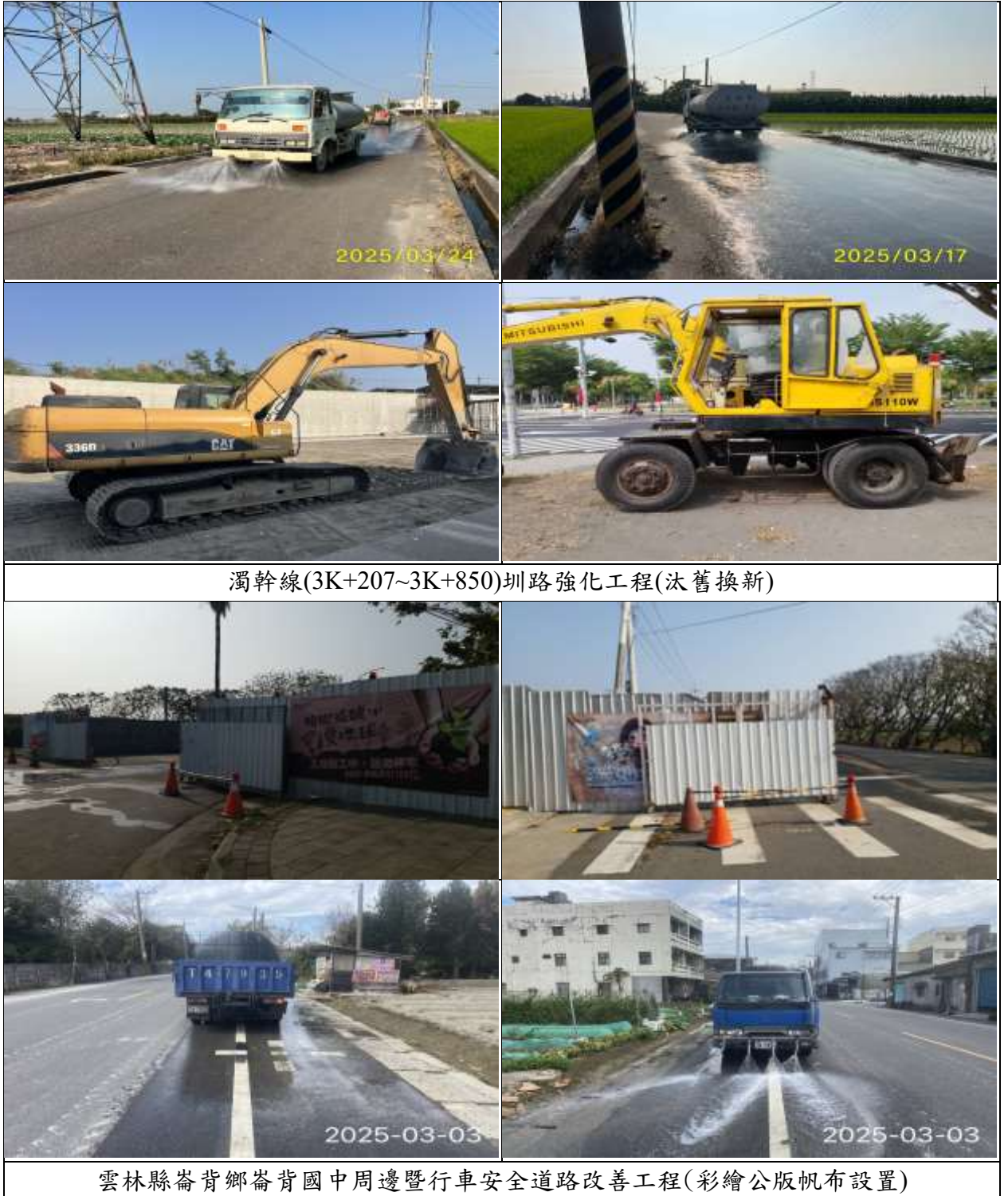
圖 2.4-1 替代工地之執行成效圖(4/4)
