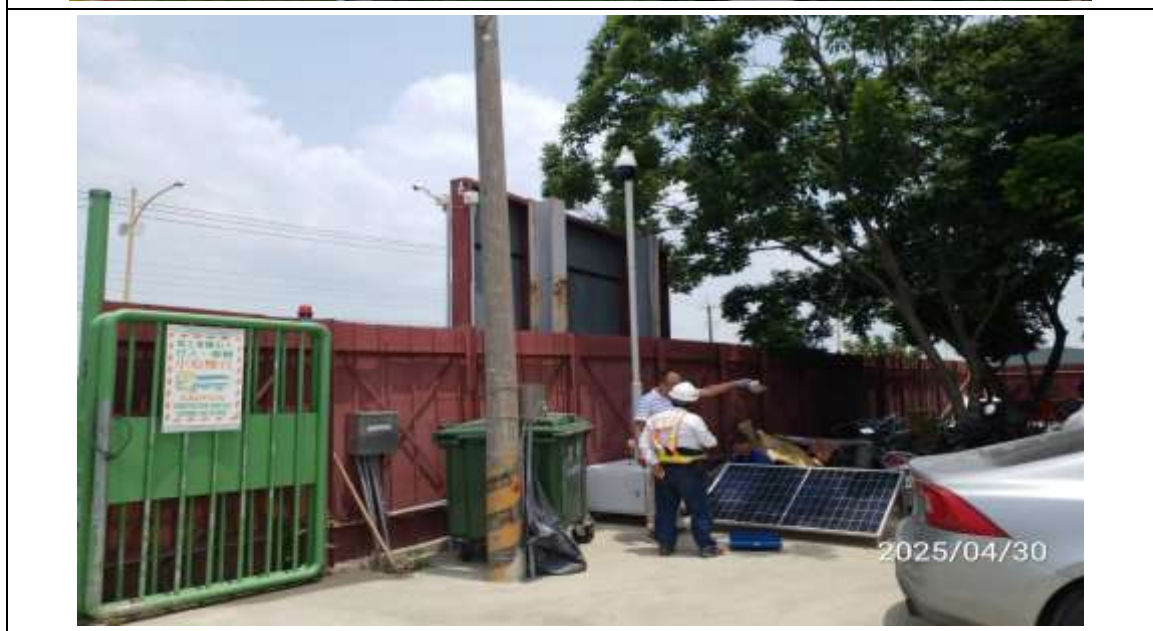
圖 9.4-9 第 9 處營建工地智能環保哨兵設置圖
