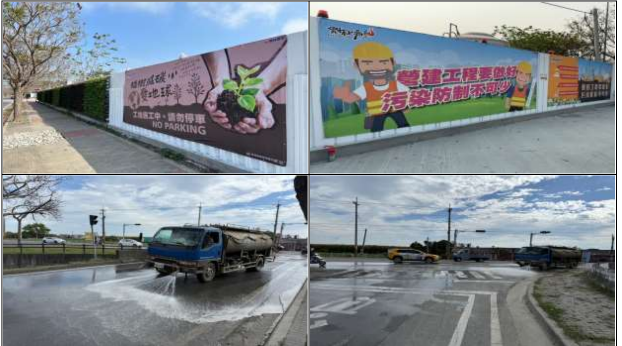
虎尾營區新建統包工程(彩繪公版帆布設置)
