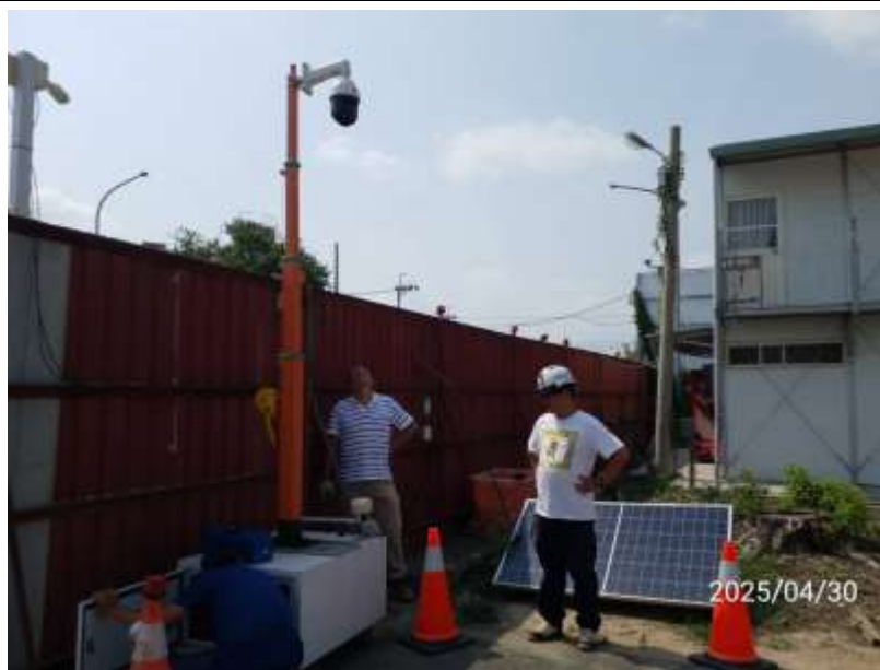
圖 9.4-10 第 10 處營建工地智能環保哨兵設置圖
