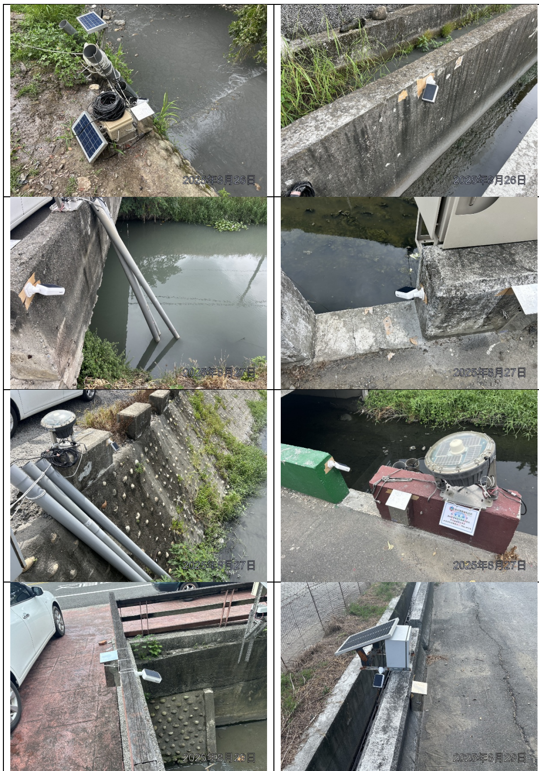
圖4.5-49 太陽能監測器安裝情形
