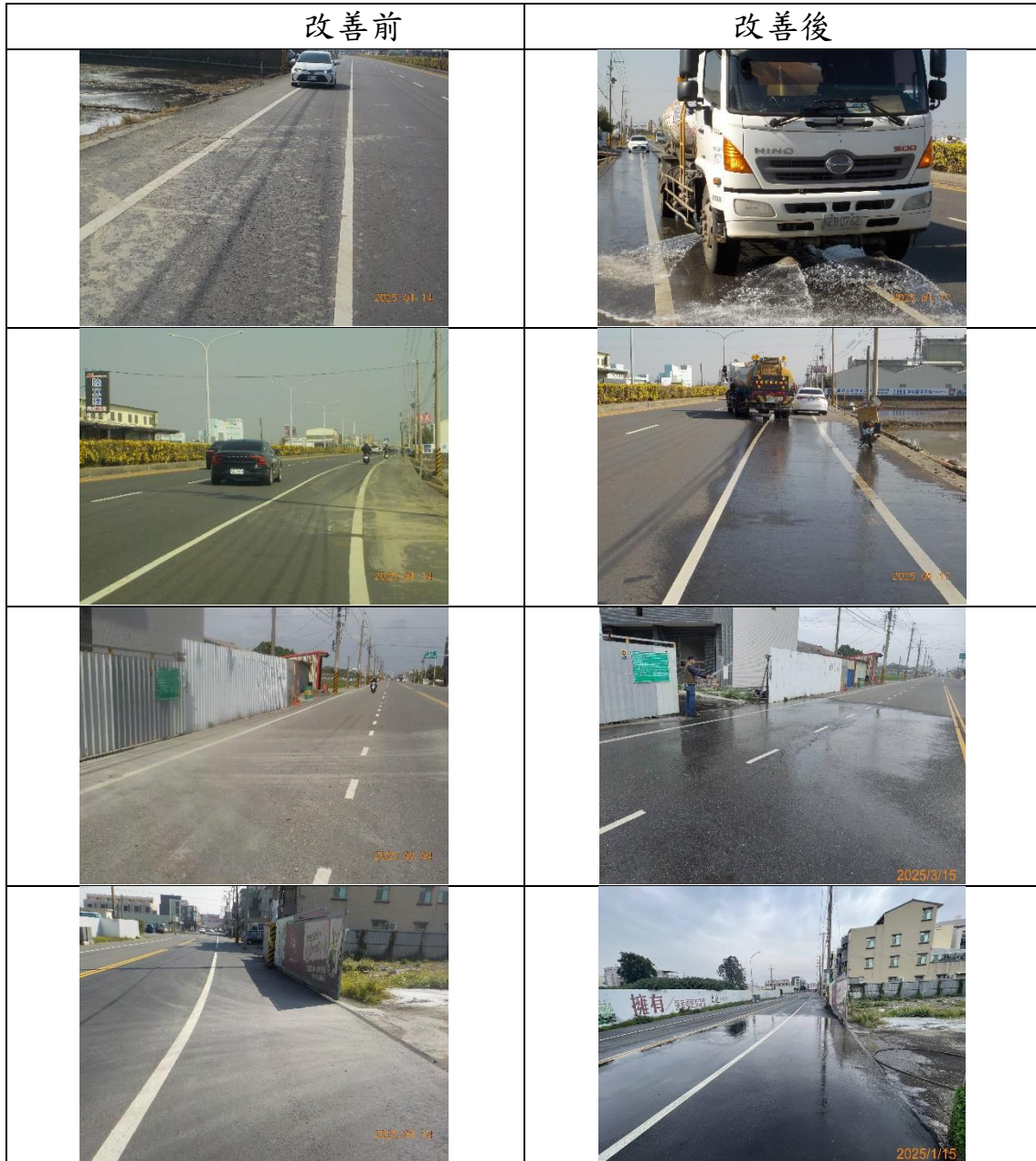
圖 6.2-4 道路髒污熱點巡查髒污改善情形
