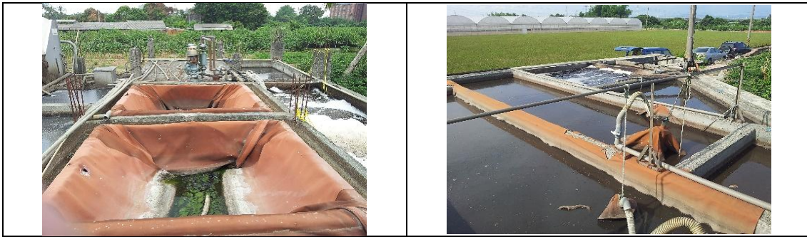
圖 4.1.1-10、厭氣設備損壞之現況
