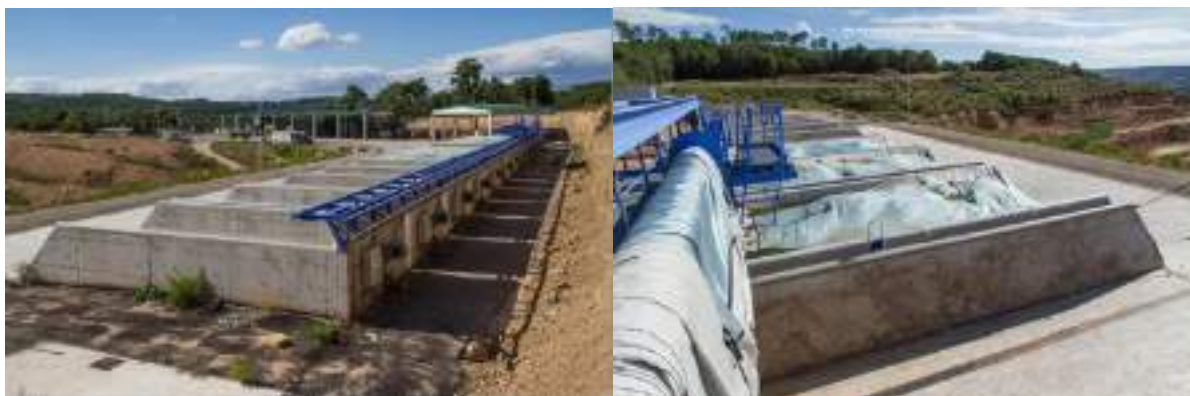
圖 7.4.1-2 露天堆置曬乾區設施構造現況照片
