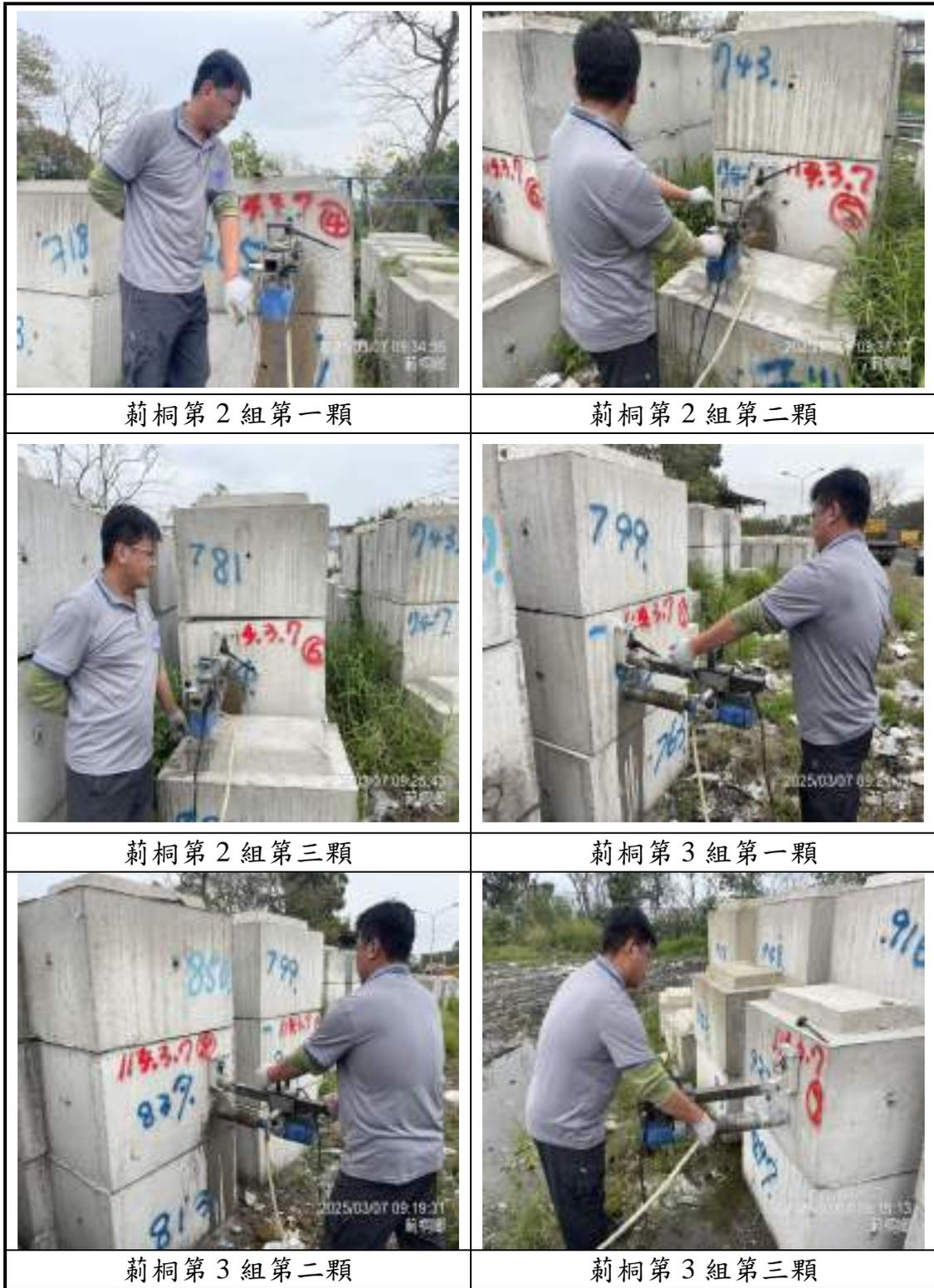
圖 6.2-3 立方磚鑽心試驗現場採樣情形(5/7)
