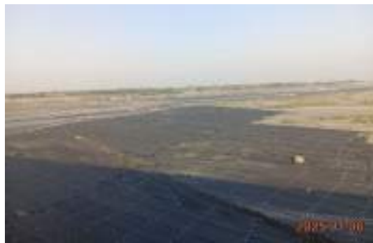
1 西螺鎮溪州大橋上
