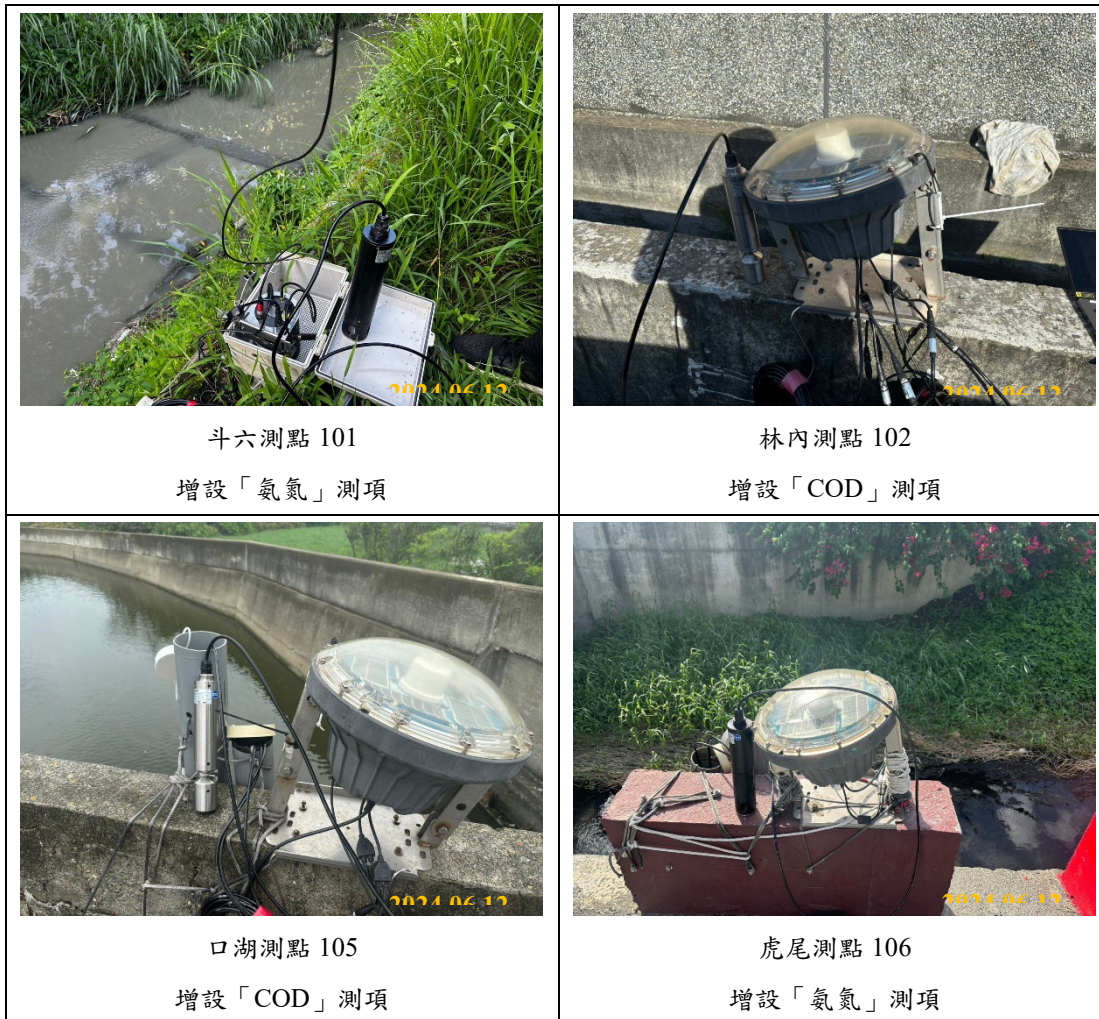
圖4.5-41 新設測項完工照片
