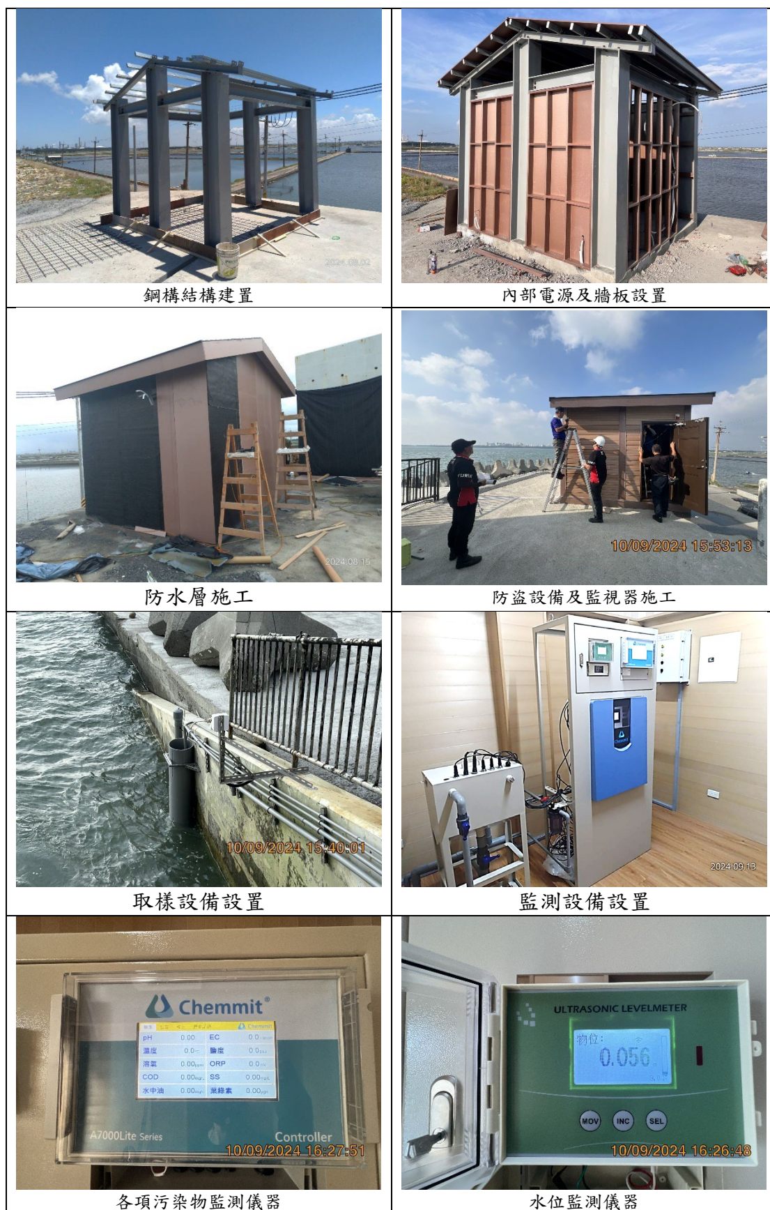
圖4.6-12 海域水質監測站現場建置過程情形
