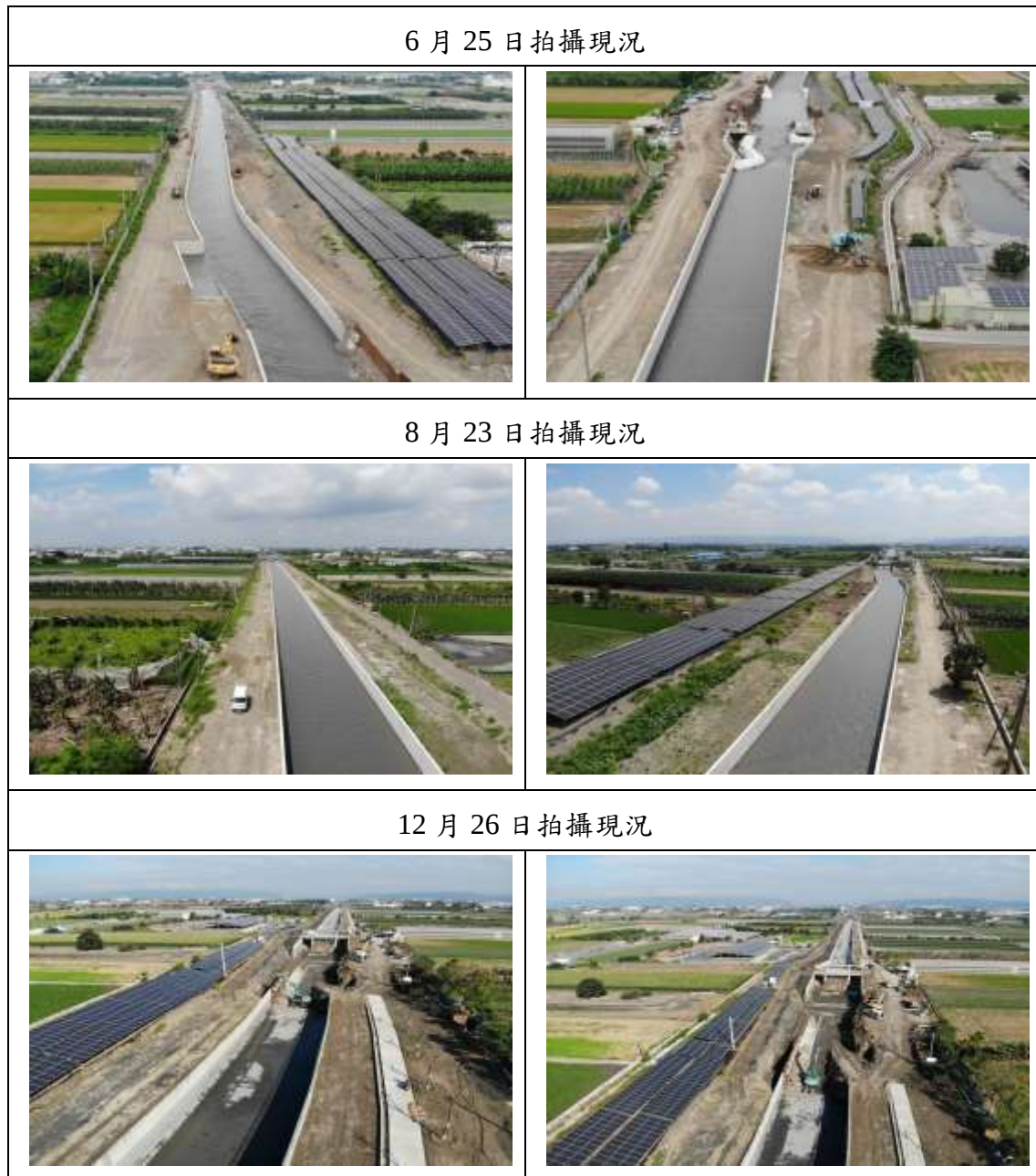
圖 9.1-7 濁幹線(5K+200~5K+890)改善工程空拍作業變化對照圖
