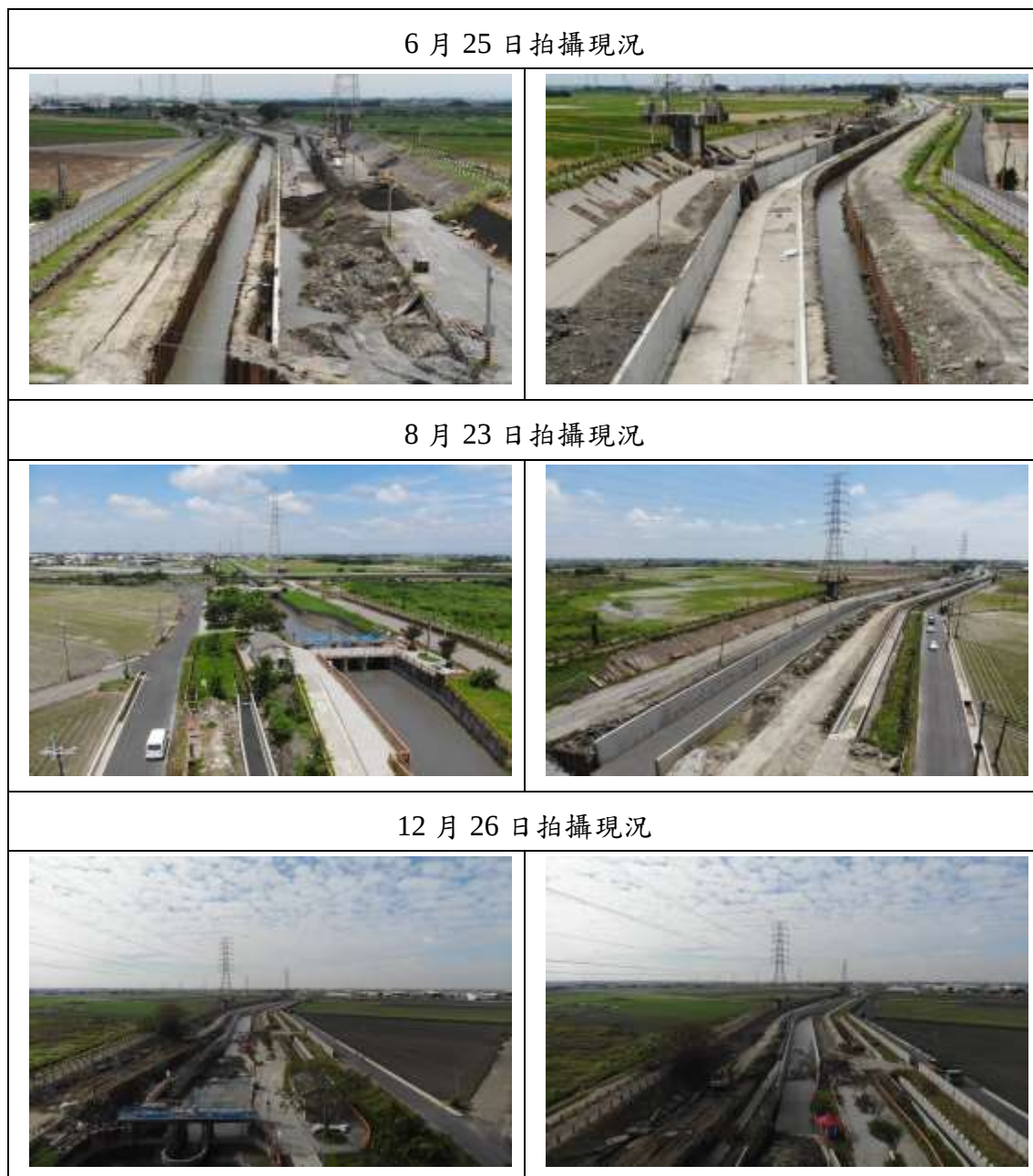
圖 9.1-17 濁幹線(25K+403.3~25K+830)改善工程空拍作業變化對照圖
