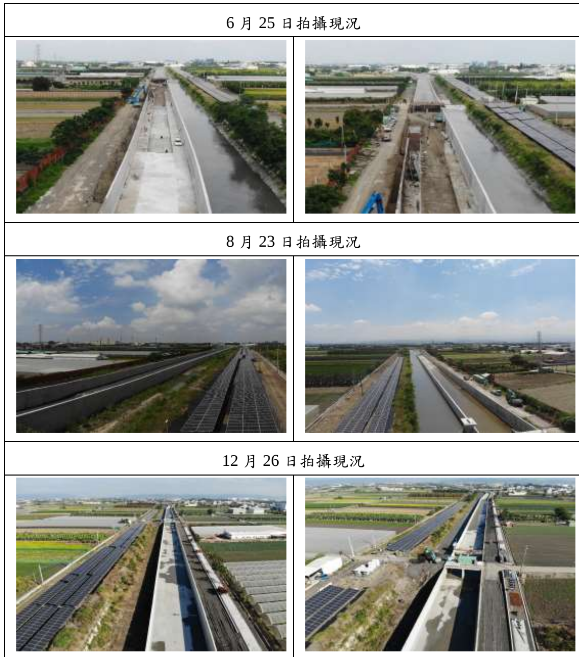
圖 9.1-9 濁幹線(6K+540~7K+225)改善工程空拍作業變化對照圖
