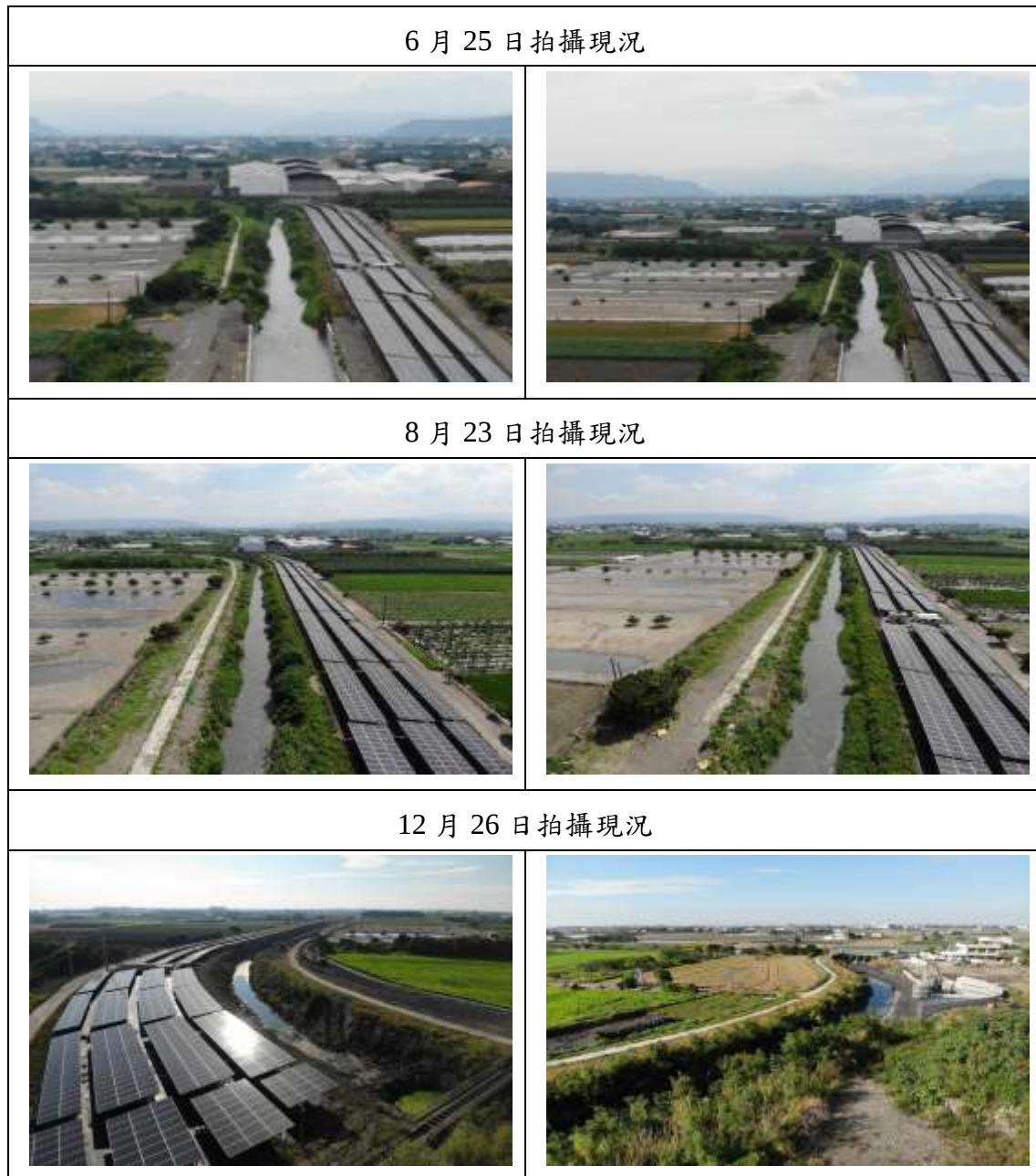
圖 9.1-4 濁幹線(3K+207~3K+850)圳路強化工程空拍作業變化對照圖
