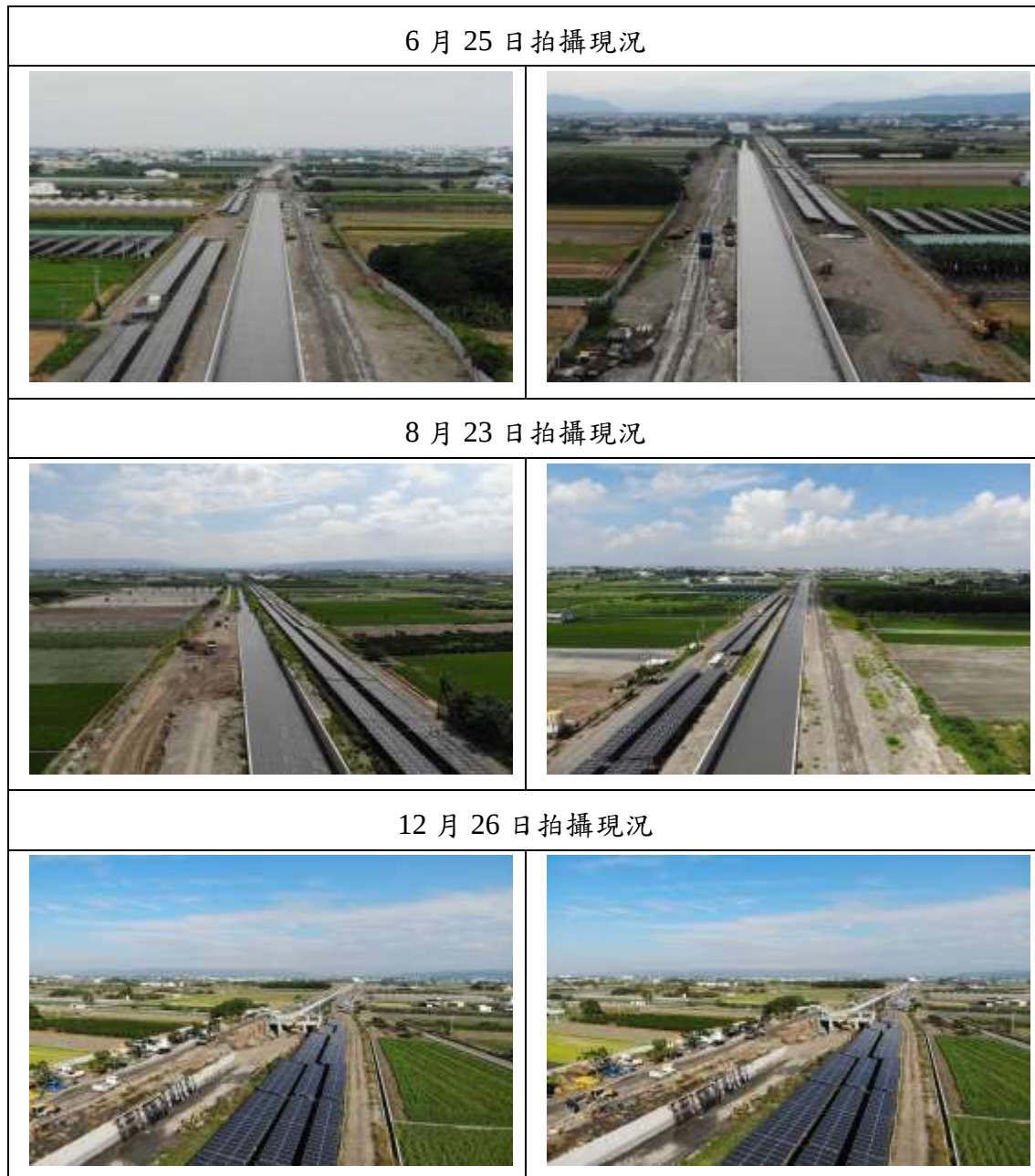
圖 9.1-5 濁幹線(3K+850~4K+618.3)改善工程空拍作業變化對照圖
