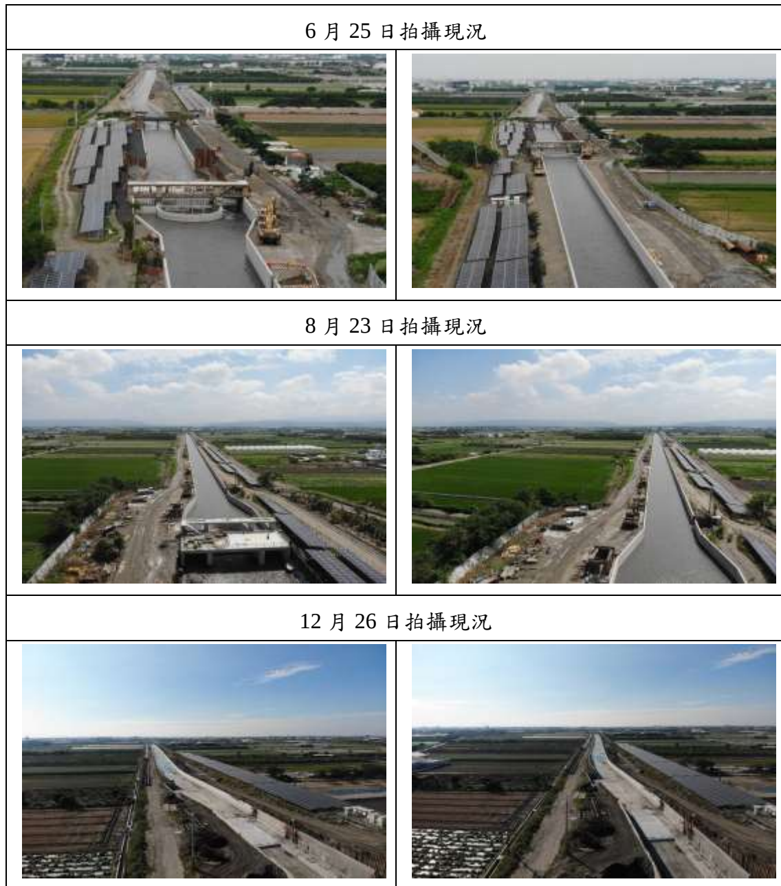
圖 9.1-6 濁幹線(4K+618.3~5K+200)改善工程空拍作業變化對照圖
