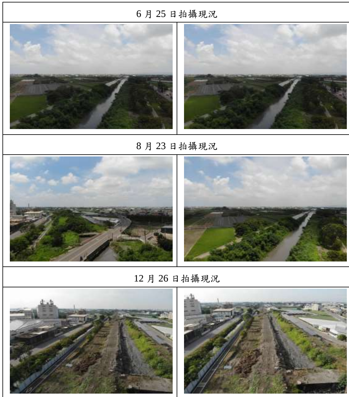
圖 9.1-15 濁幹線(11K+000~11K+725)改善工程空拍作業變化對照圖
