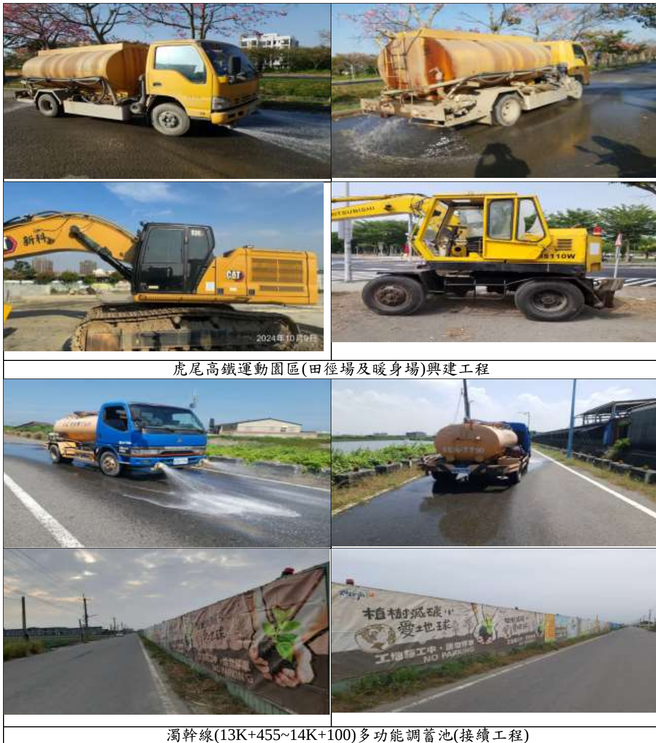
圖 2.4-1 替代工地之執行成效圖(4/4)
