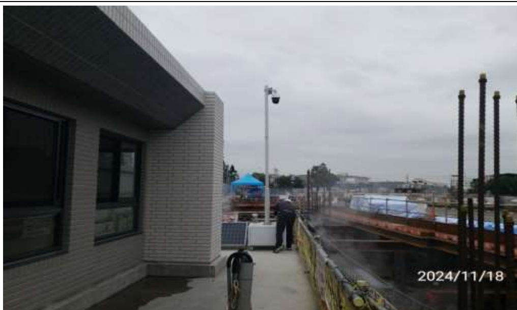
圖 9.3-23 第 22 營建工地智能環保哨兵設置圖
