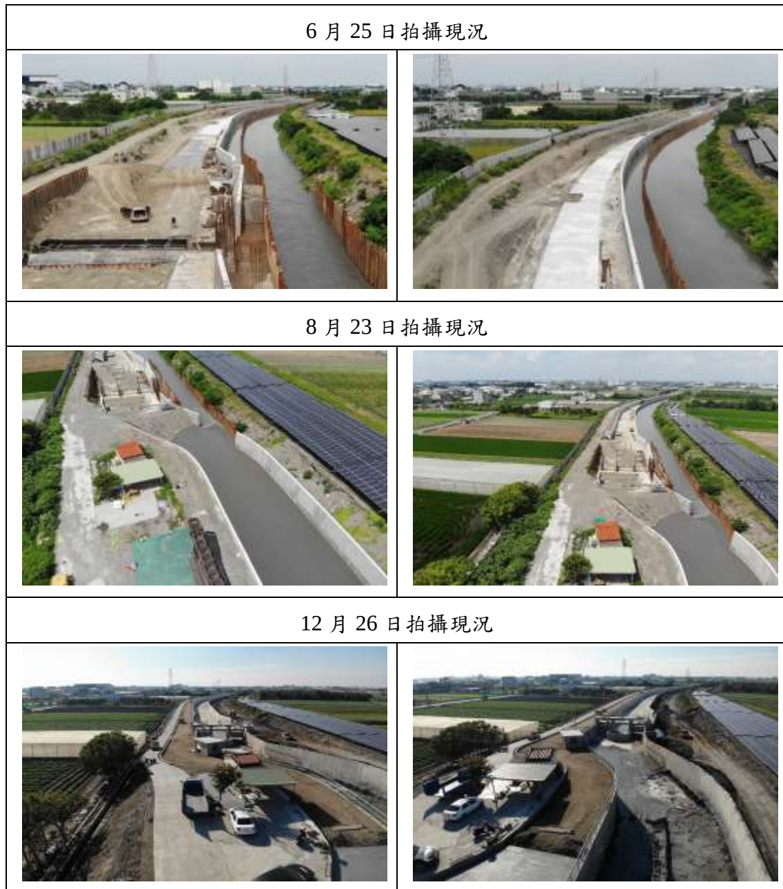
圖 9.1-8 濁幹線(5K+890~6K+540)改善工程空拍作業變化對照圖
