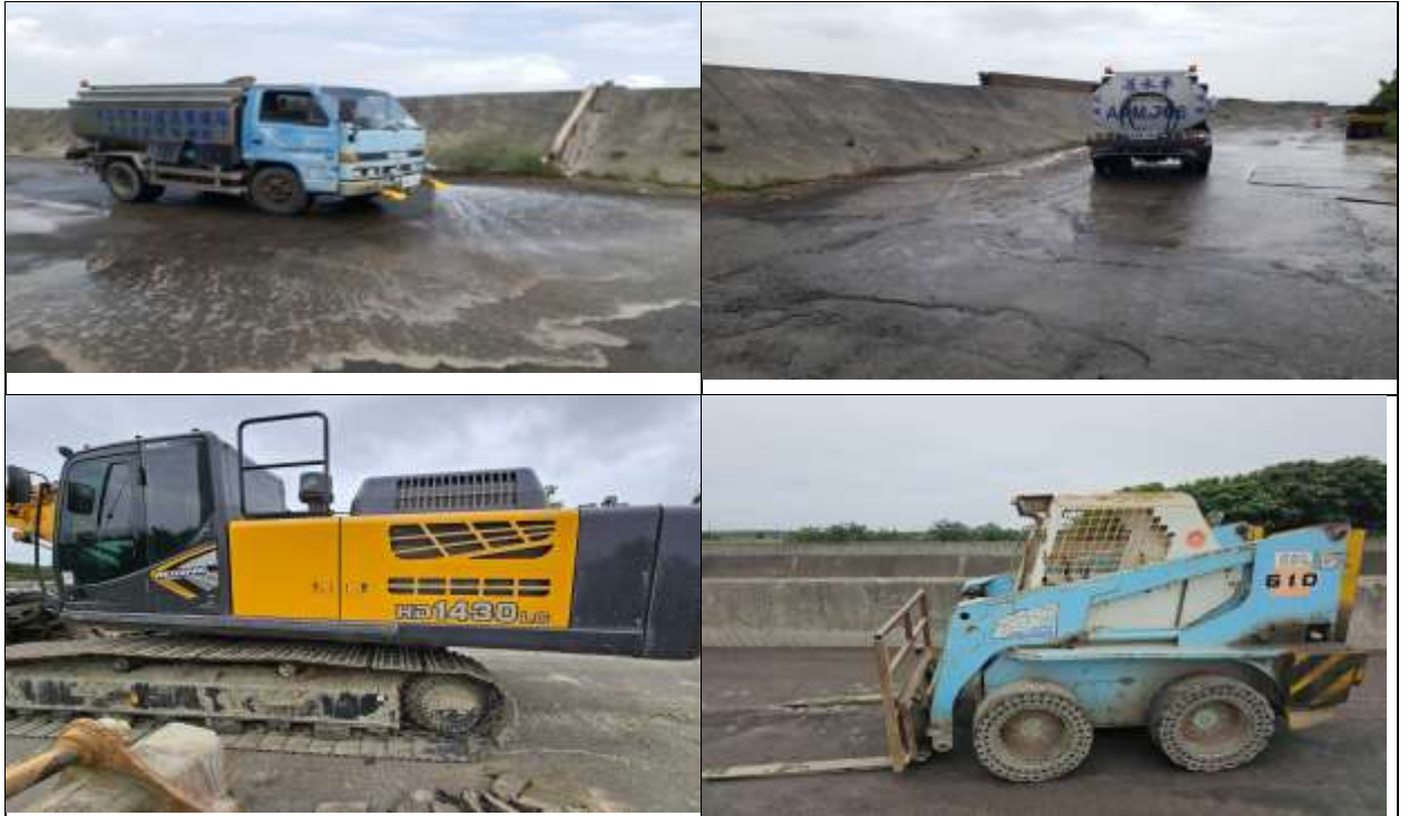
161kV 台區先~台區線電纜管路設計及施工統包工程(汰舊換新)
