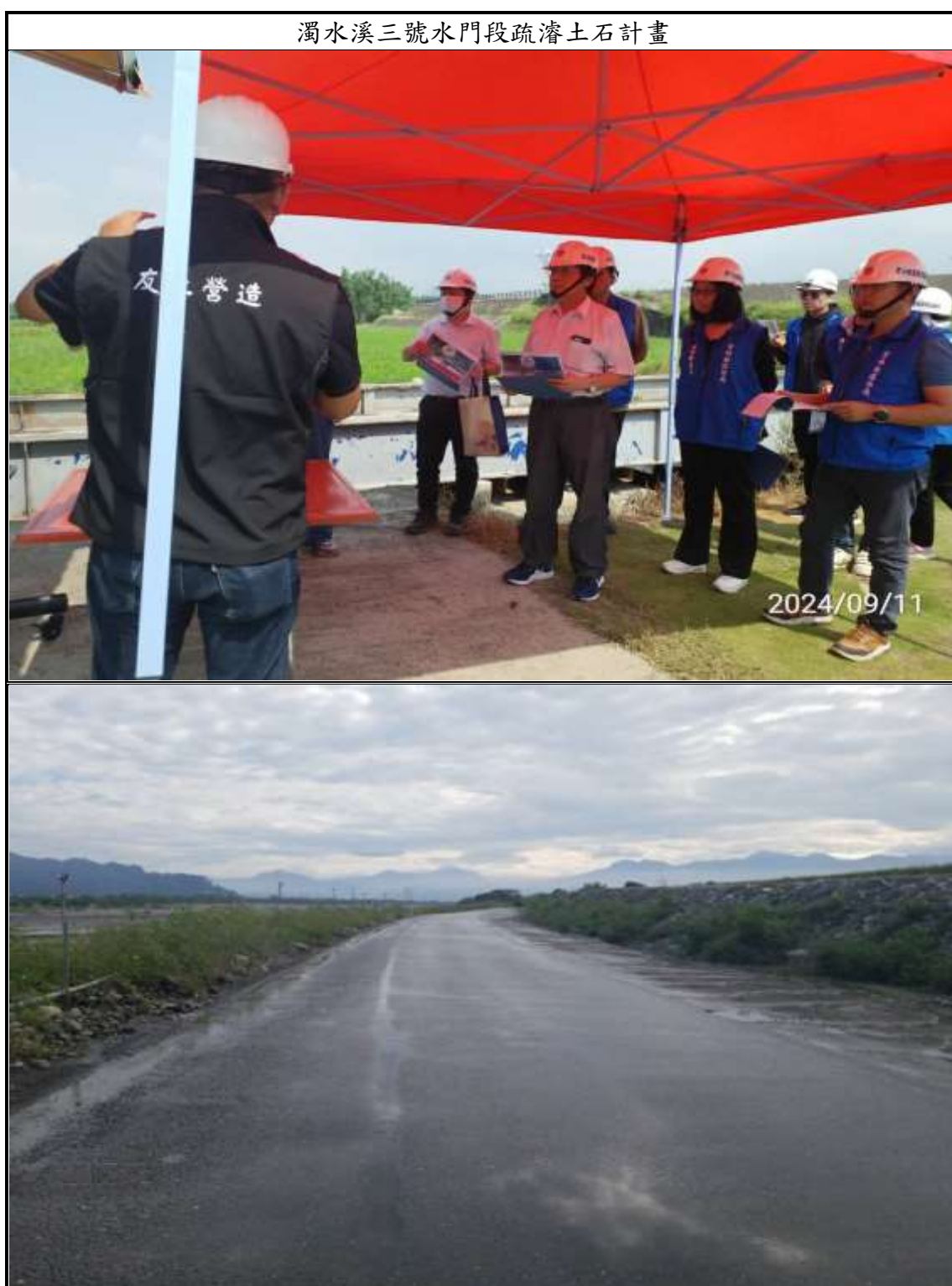
圖 2.6-1 優良營建工地評鑑現場實況圖(4/4)
