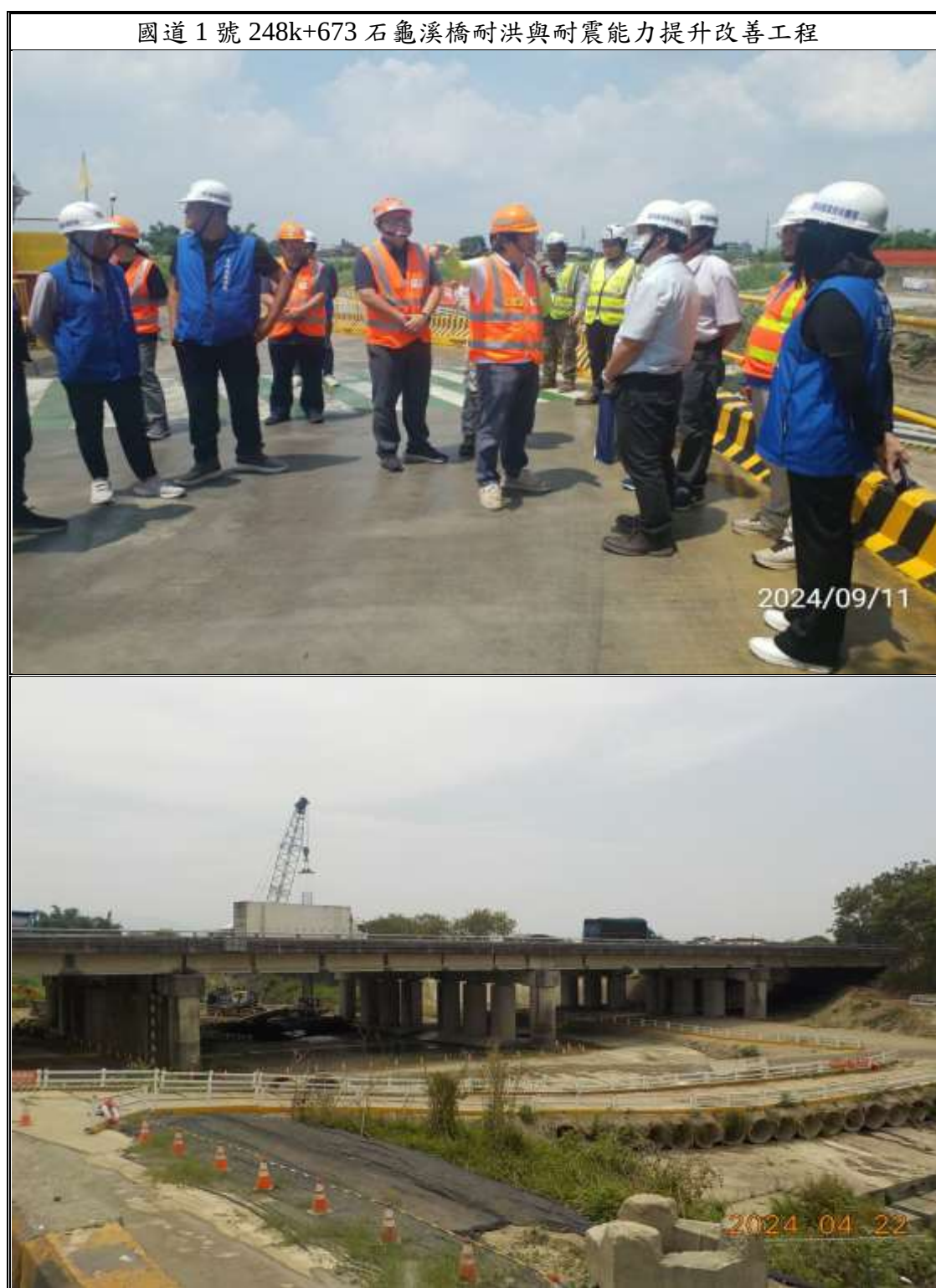
圖 2.6-1 優良營建工地評鑑現場實況圖(3/4)
