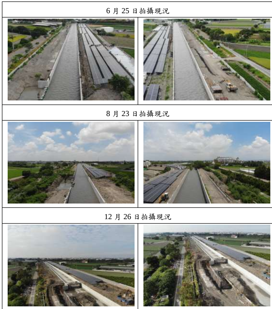
圖 9.1-16 濁幹線(11K+725~12K+535)改善工程空拍作業變化對照圖
