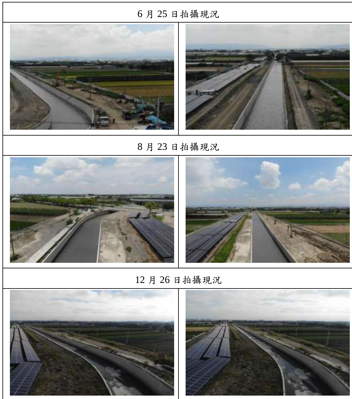
圖 9.1-13 濁幹線(8K+920~9K+497)圳路強化工程空拍作業變化對照圖
