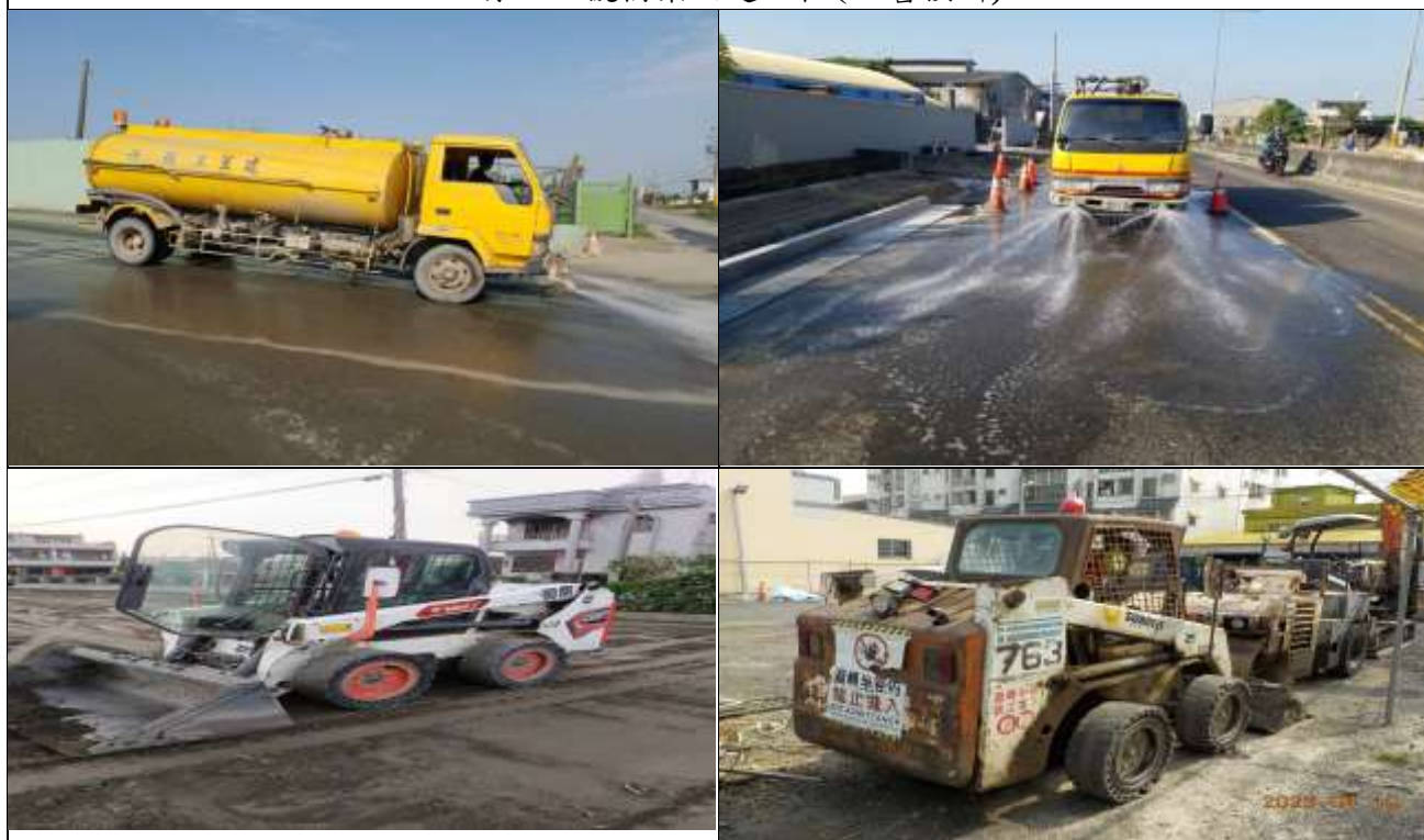
虎尾鎮 632 高地公園二期營造工程(汰舊換新)
