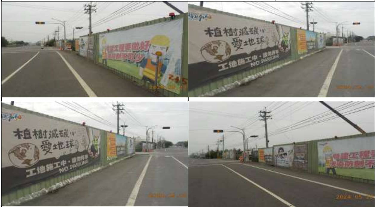
濁幹線(7K+728~8K+450)圳路強化工程(彩繪公版帆布設置)
