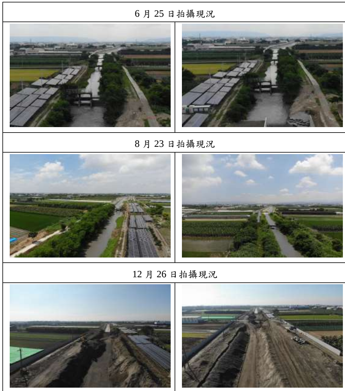
圖 9.1-12 濁幹線(8K+450~8K+920)圳路強化工程空拍作業變化對照圖
