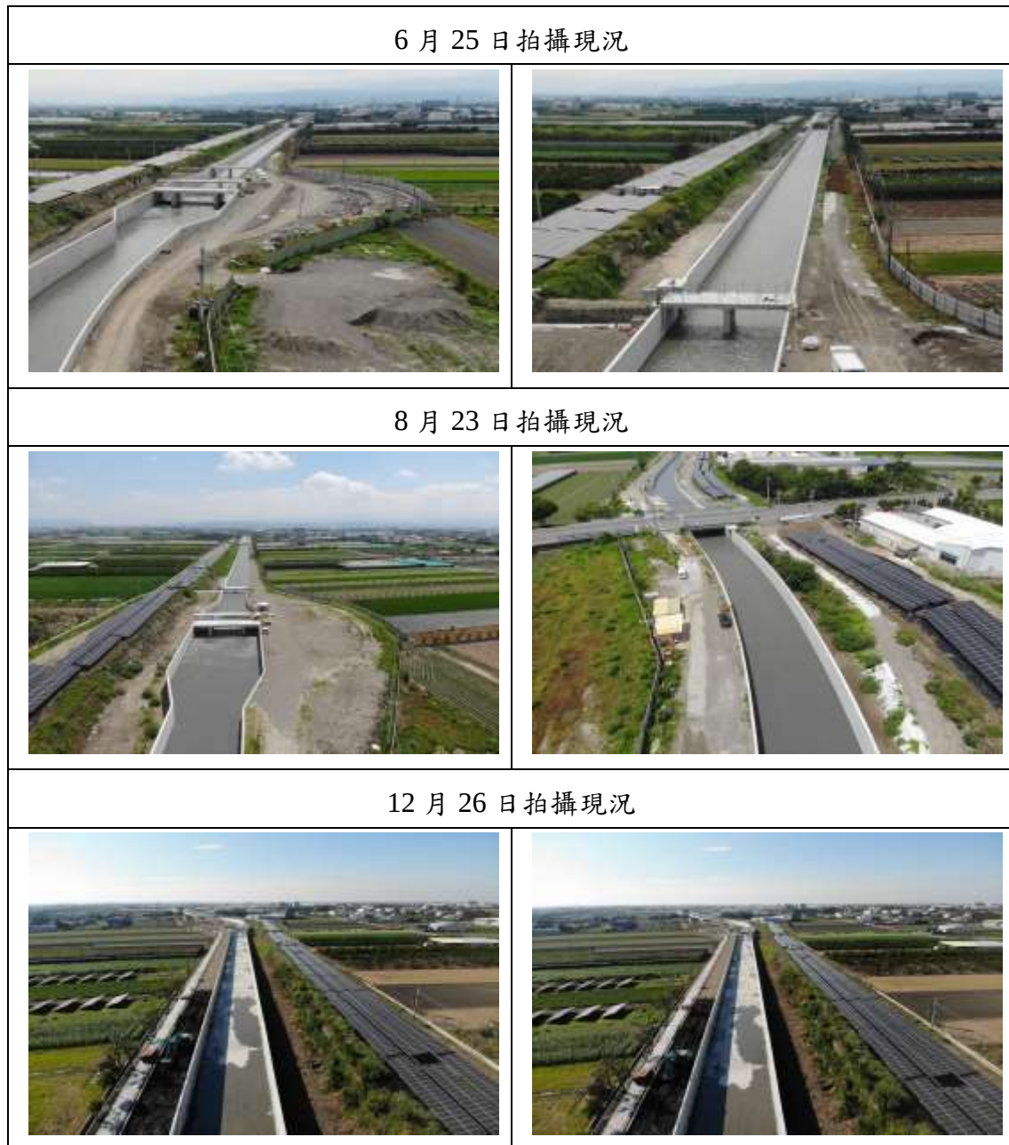
圖 9.1-10 濁幹線(7K+225~7K+728)改善工程空拍作業變化對照圖
