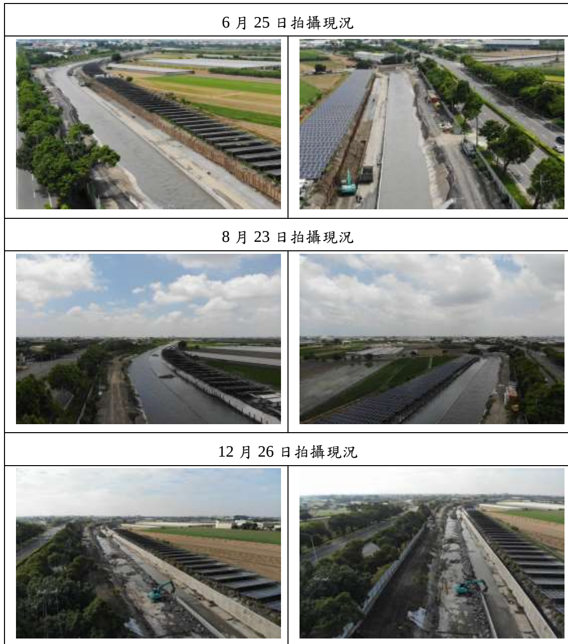
圖 9.1-14 濁幹線(9K+497~10K+300)圳路強化工程空拍作業變化對照圖
