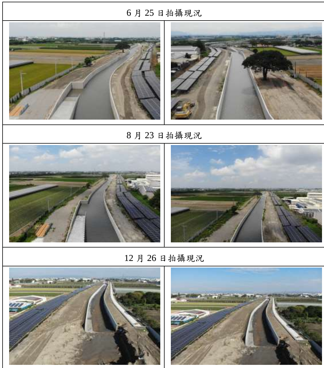
圖 9.1-11 濁幹線(7K+728~8K+450)圳路強化工程空拍作業變化對照圖
