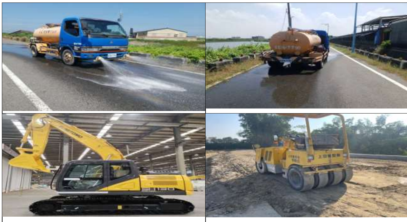
口湖 N30 號橋梁改建工程(汰舊換新)
