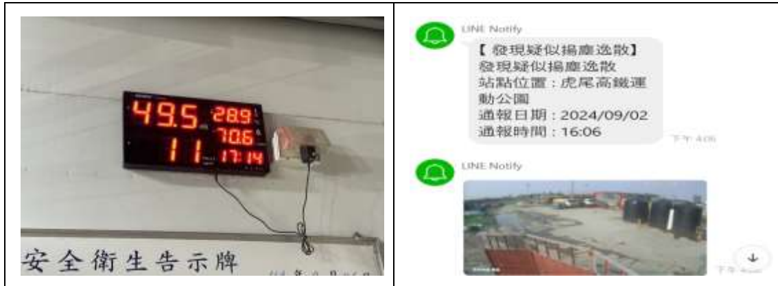
圖 9.2-1 第 1 處營建工程運用科技化空氣污染防治設施照片
