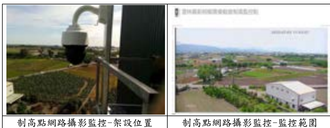
圖 3.4.2-12 AI 煙霧主動通報系統安裝情形(莿桐鄉稻米產業館)
