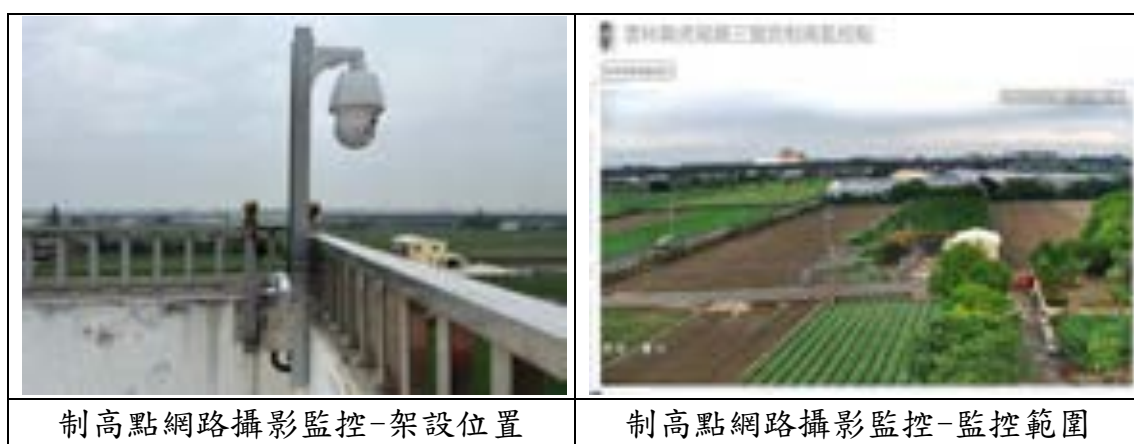
圖 3.4.2-13 AI 煙霧主動通報系統安裝情形(虎尾鎮三寶宮)
