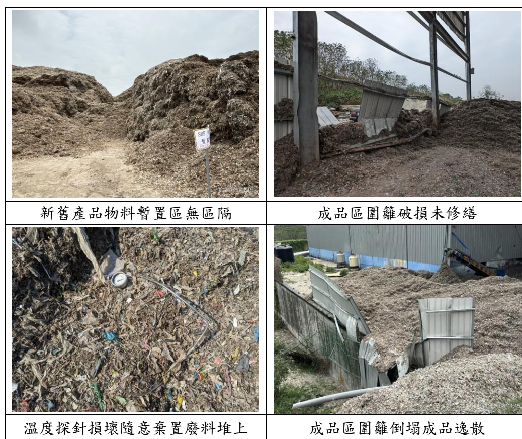
圖 4.1-2 ZWS 設備現場查核缺失樣態
