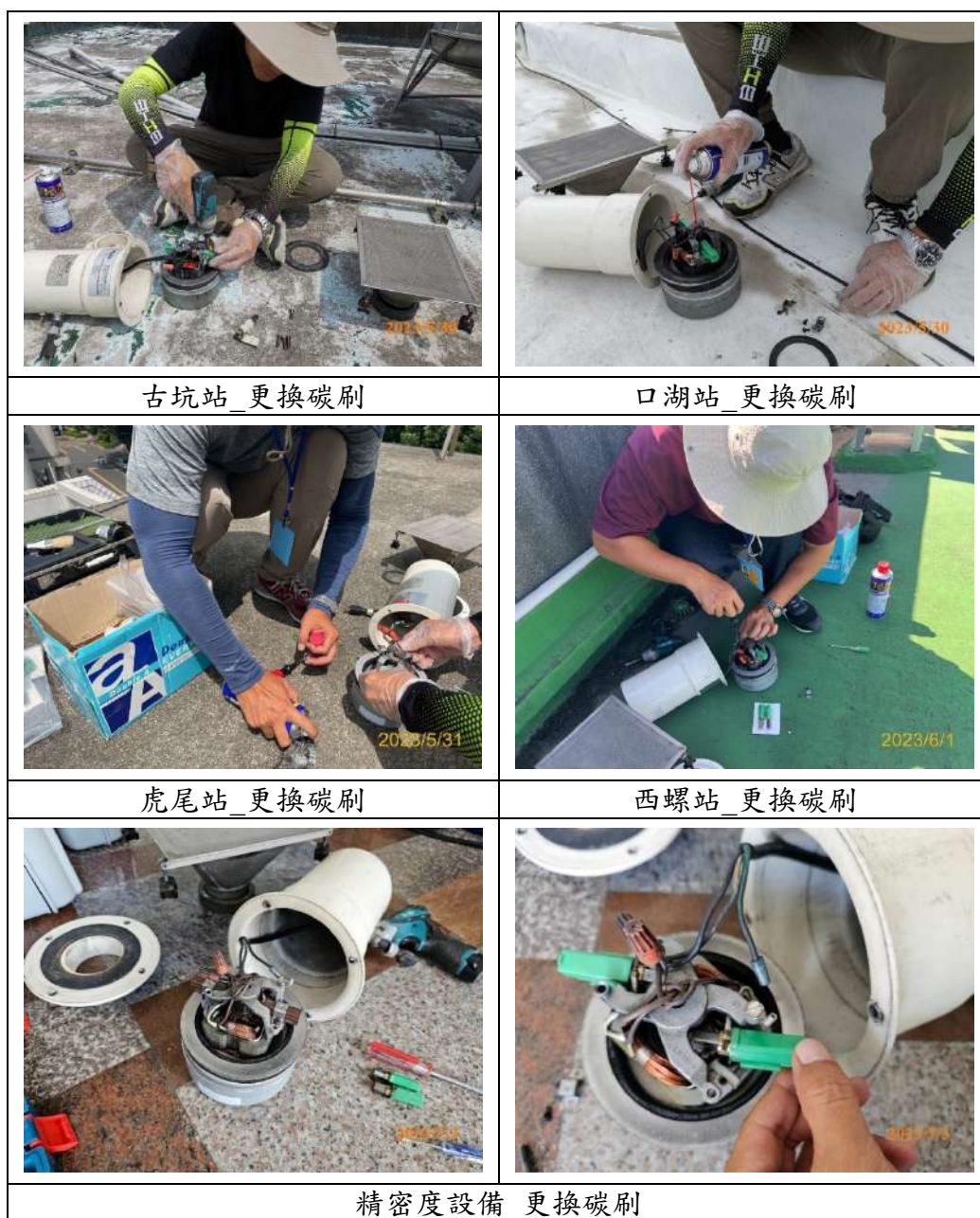
圖4.1-1 測站更換碳刷及電樞狀況
