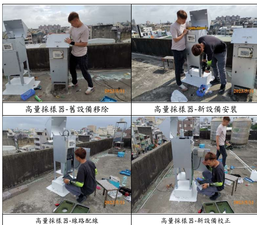
圖4.1-10 人工測站北港站汰換狀況
