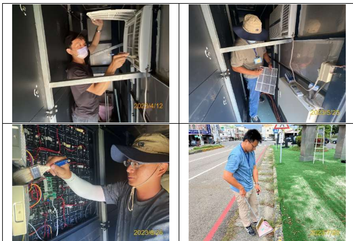
圖4.3-1 周圍環境維護及顯示看板設備維護作業
