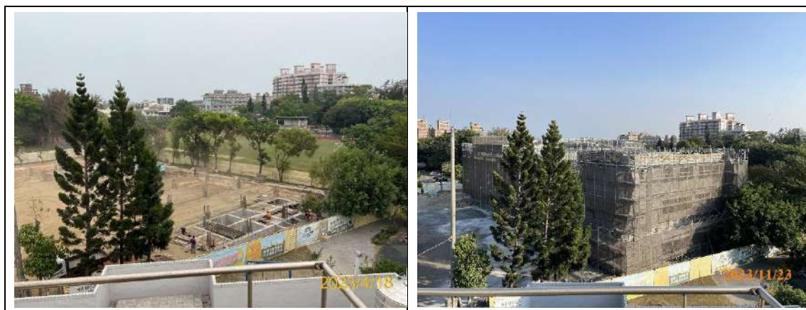
圖4.1-4 虎尾站東方有住宅營建工程
