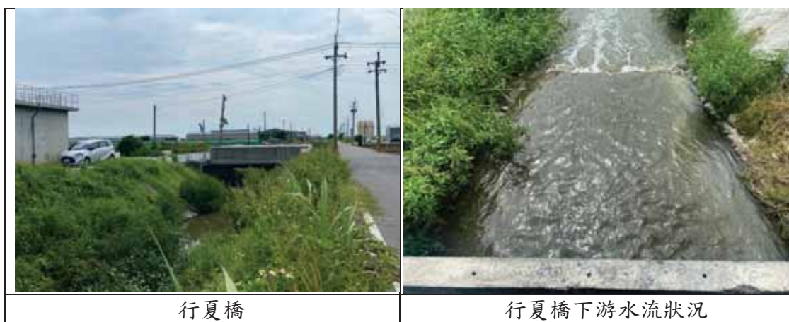
圖 4-1-9 施厝寮排水上游河段行夏橋現勘照片
