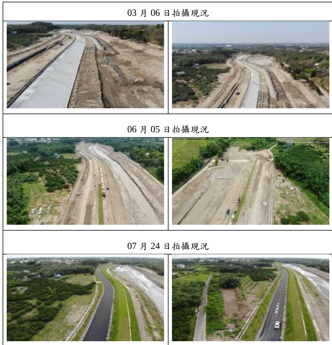
圖 9.1-6 石牛溪頂柴裡堤防改善工程 空拍作業變化對照圖
