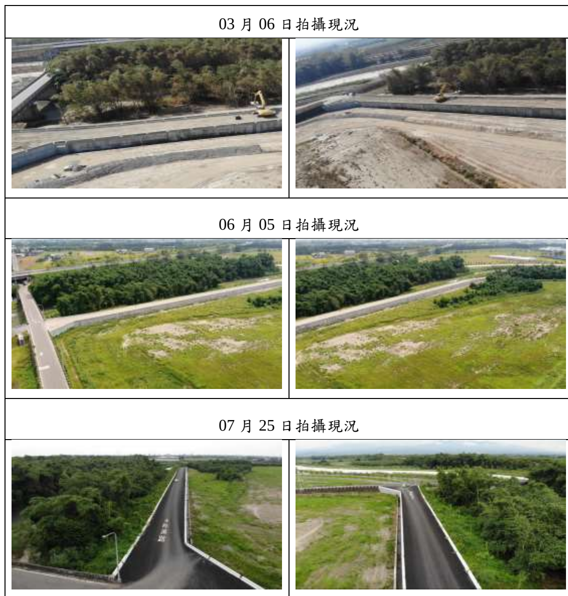
圖 9.1-7 石牛溪東明將軍堤段(一期)改善工程(三工區) 空拍作業變化對照圖
