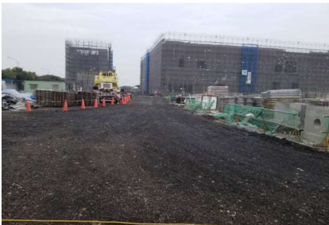
圖 6.6-1 優良營建工地評鑑現場實況圖(3/7)
