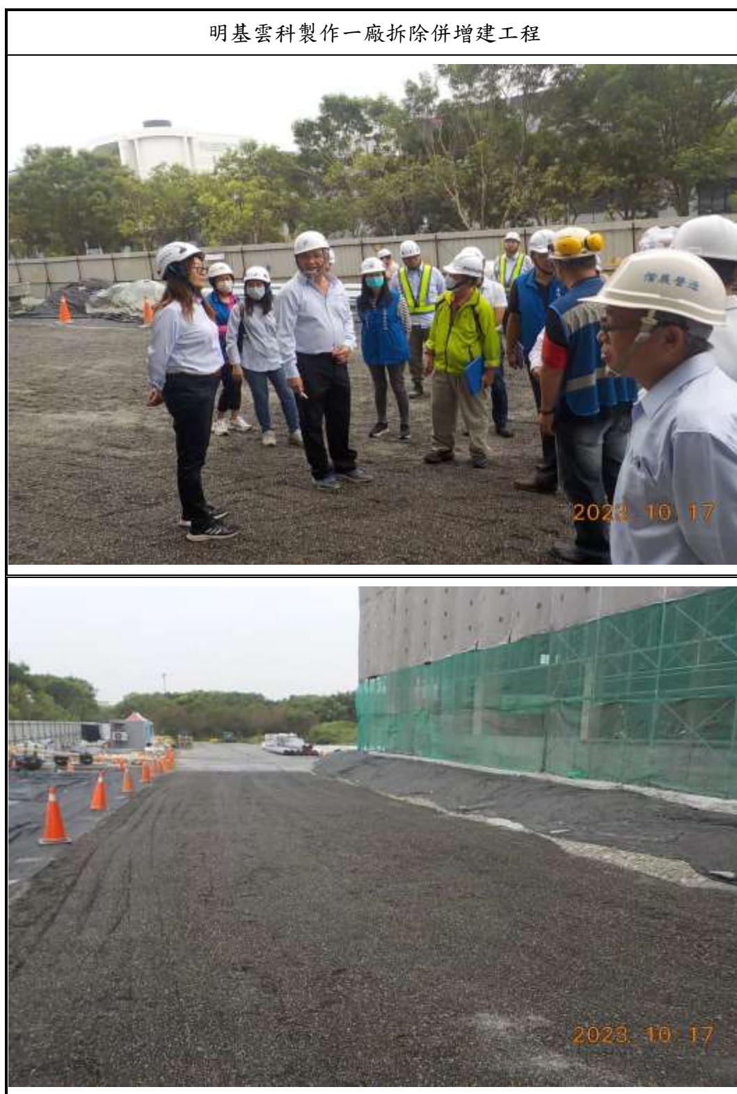
圖 6.6-1 優良營建工地評鑑現場實況圖(2/7)
