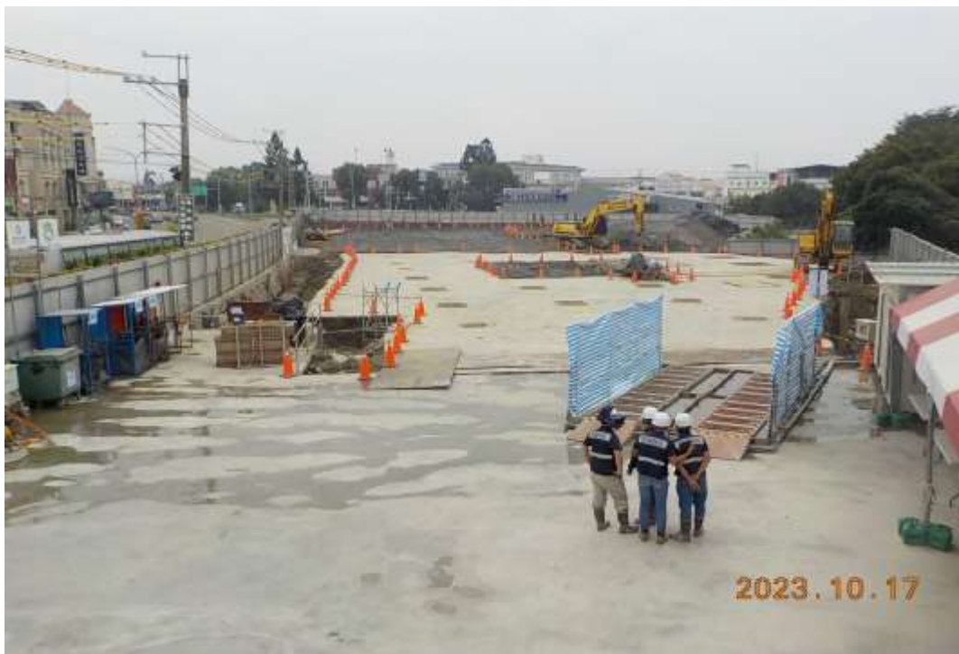
圖 6.6-1 優良營建工地評鑑現場實況圖(1/7)
