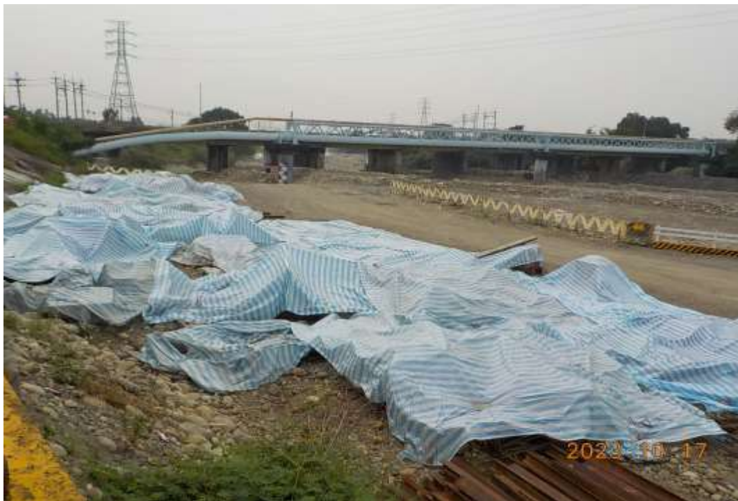
圖 6.6-1 優良營建工地評鑑現場實況圖(5/7)
