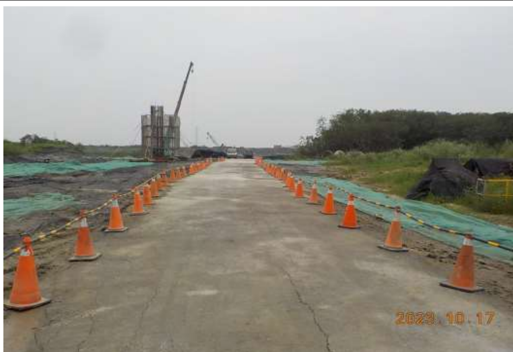
圖 6.6-1 優良營建工地評鑑現場實況圖(6/7)
