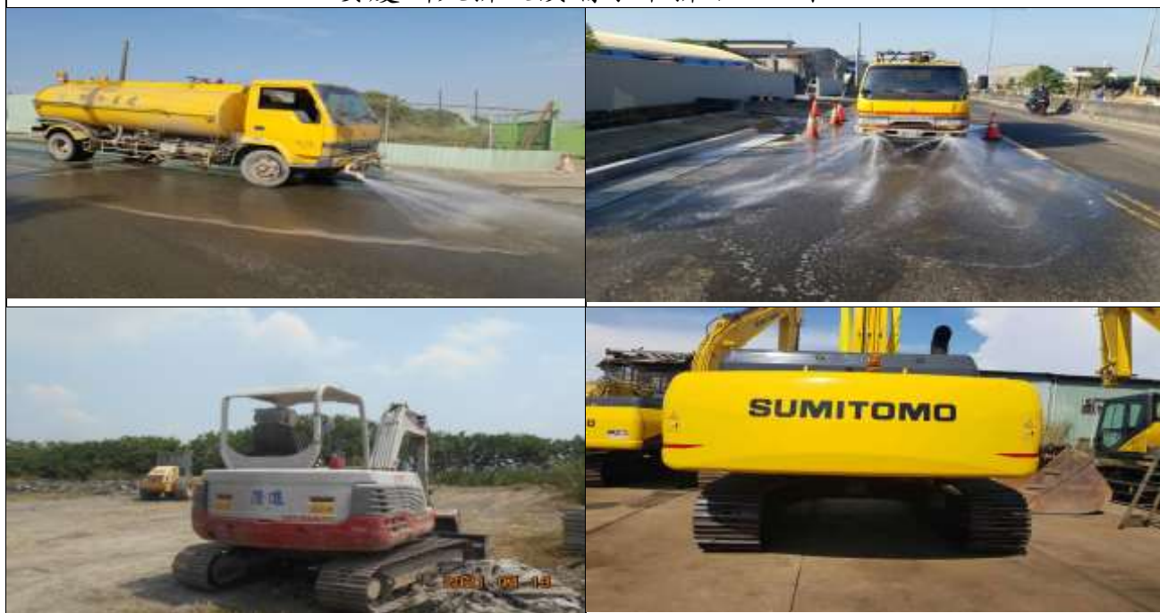
161kV 虎科~台區線電纜管路設計及施工統包工程
