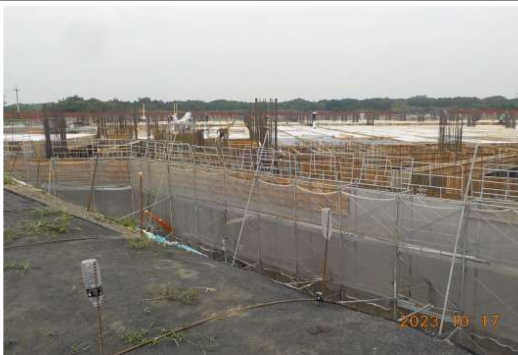
圖 6.6-1 優良營建工地評鑑現場實況圖(4/7)
