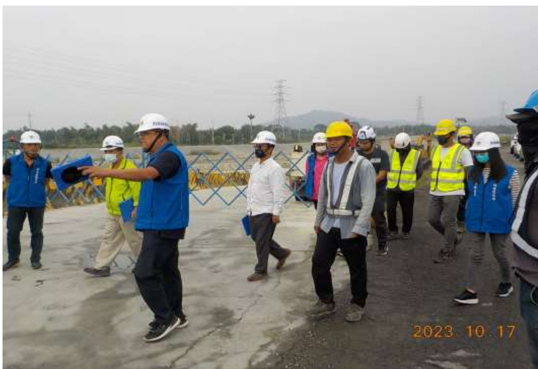
縣道 154 乙線-水碓南橋改建工程
