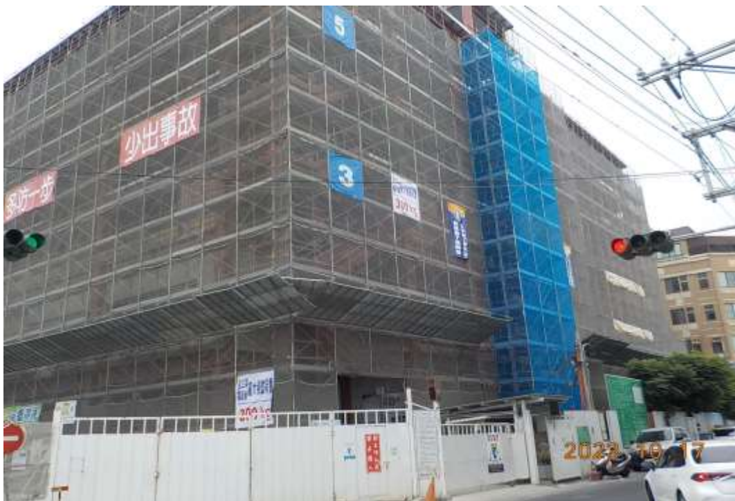
圖 6.6-1 優良營建工地評鑑現場實況圖(7/7)
