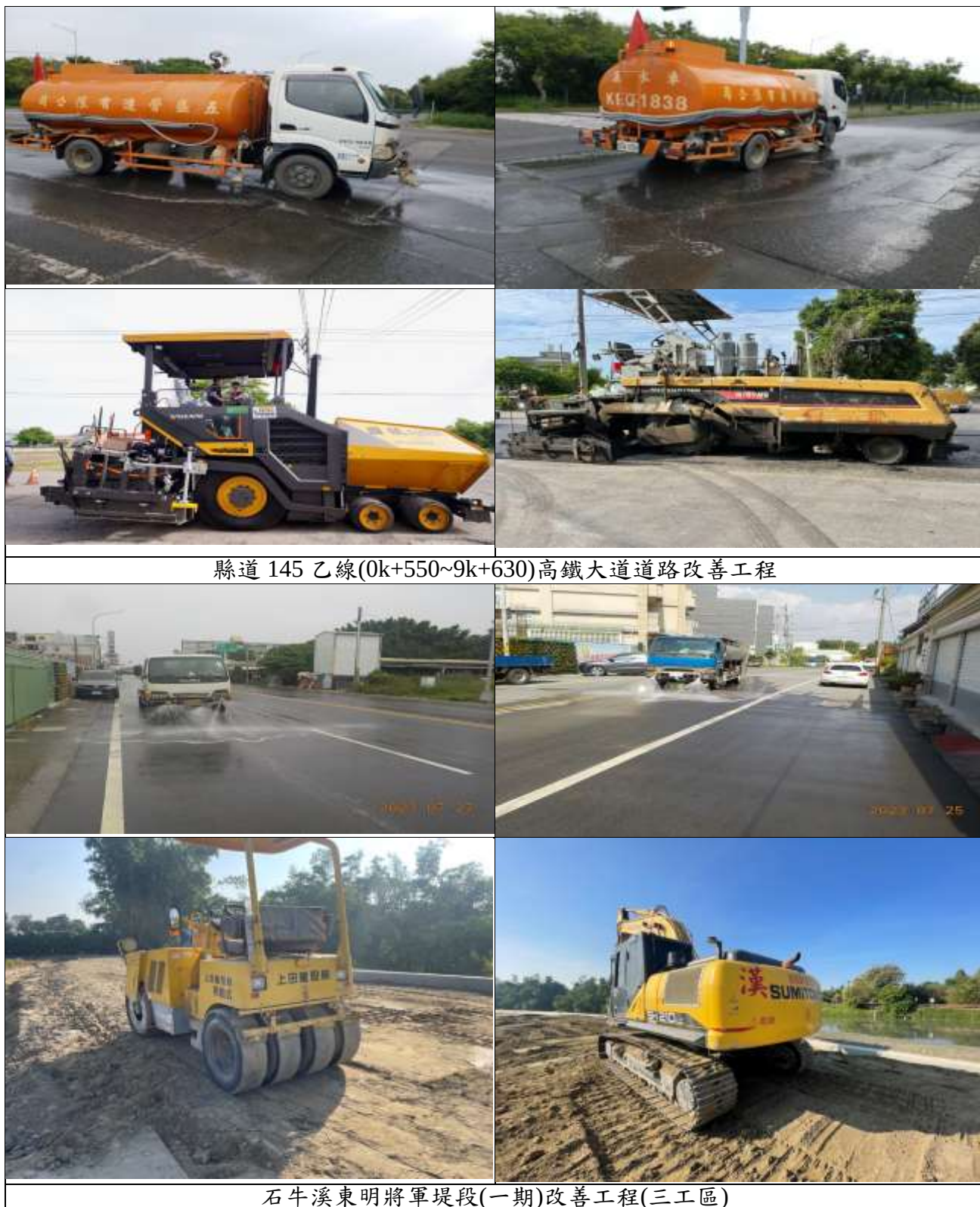
圖 2.4-1 替代工地之執行成效圖(3/3)
