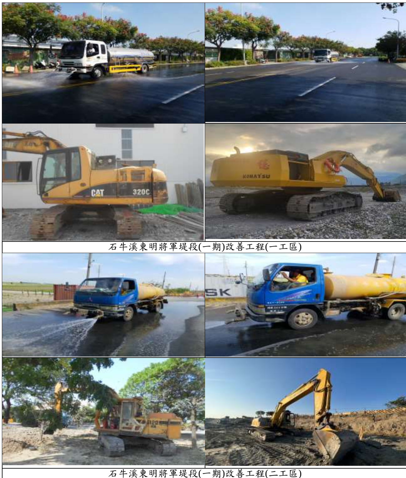
圖 2.4-1 替代工地之執行成效圖(1/3)
