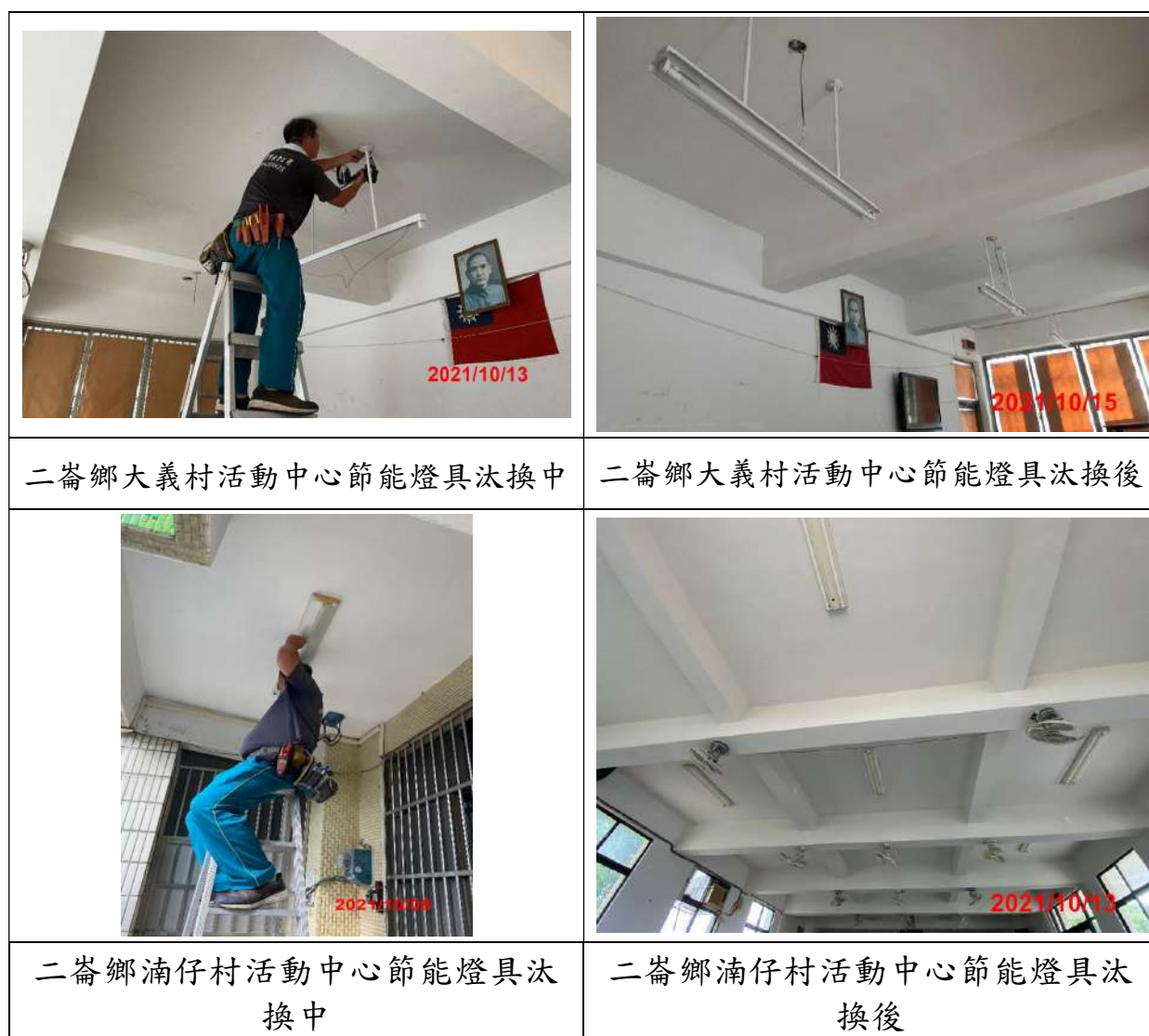
圖 4.2-2 村里活動中心節能燈具汰換情形 (1/2)
