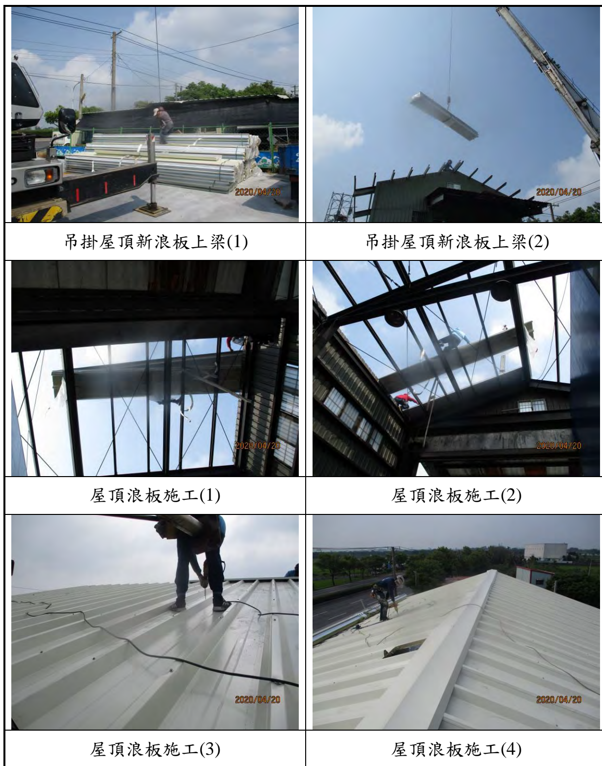
圖 7.7-4 安裝新浪板照片(施工中)
