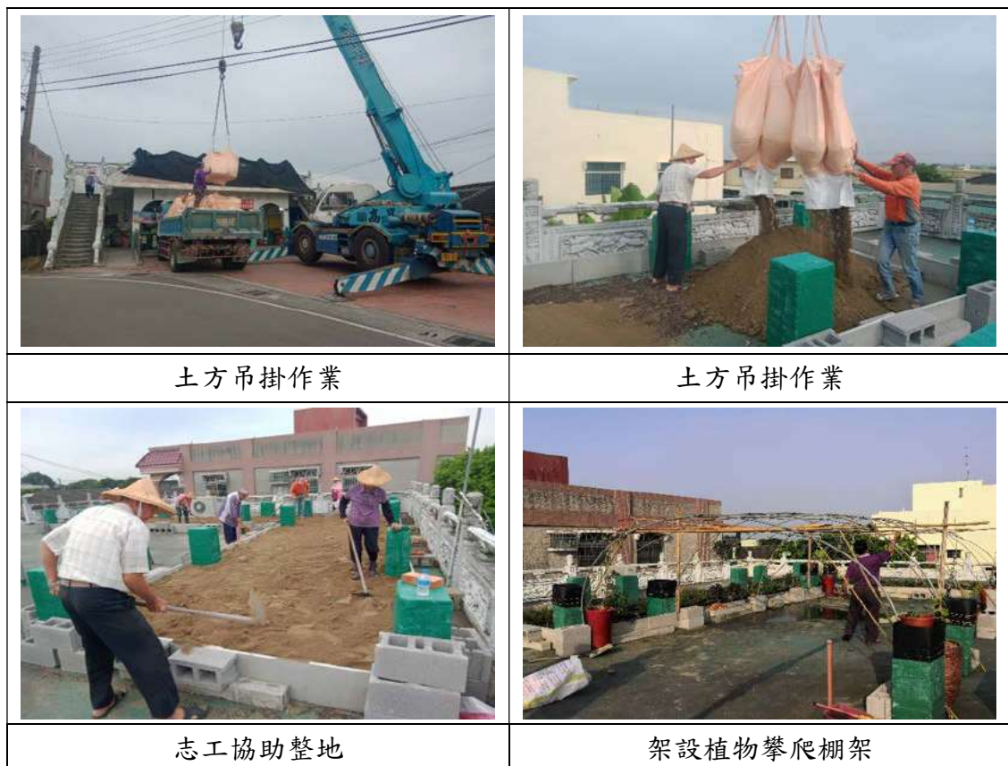
圖 6.3-5 仿生菜畦設置及花廊道架設情形
