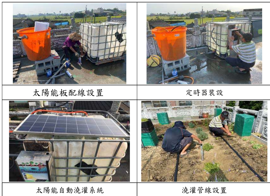
圖 6.3-7 太陽能自動澆灌系統設置情形
