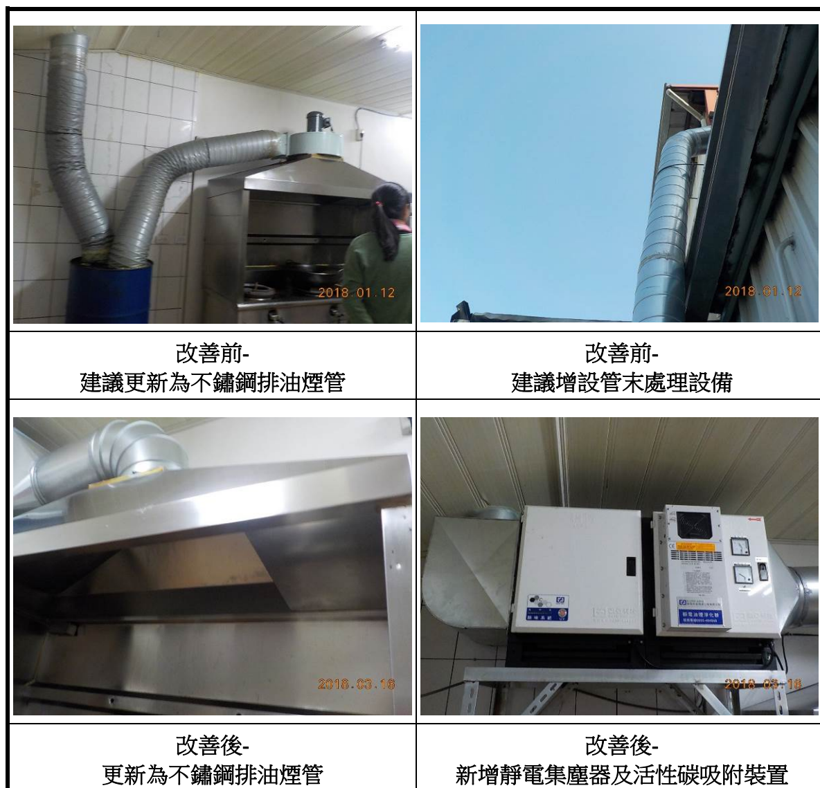
圖 4.2-1 輔導裝設油煙防制設備改善案例
