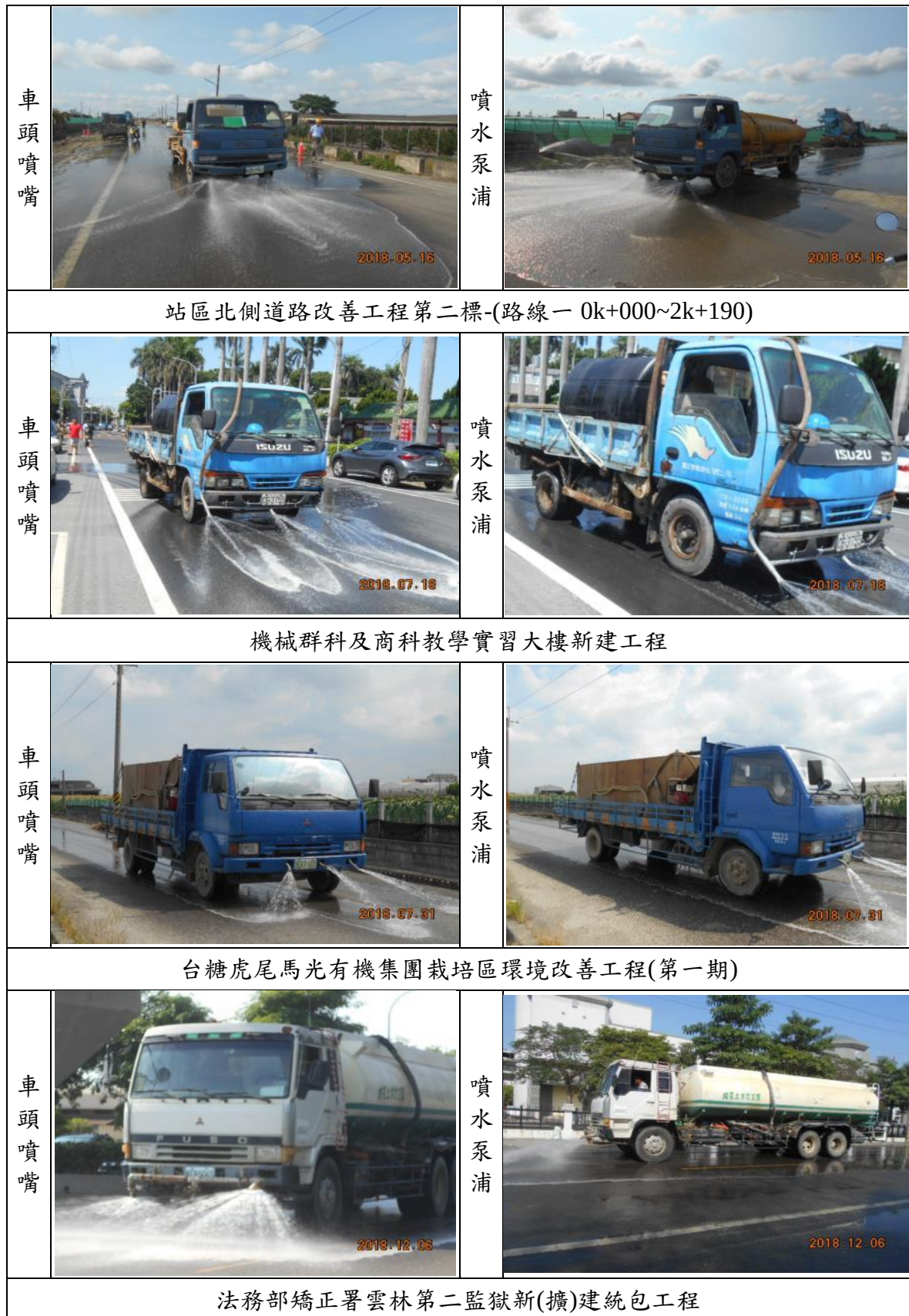
圖 6.3-1 工地洗街車符合環保署洗街車作業規範照片
