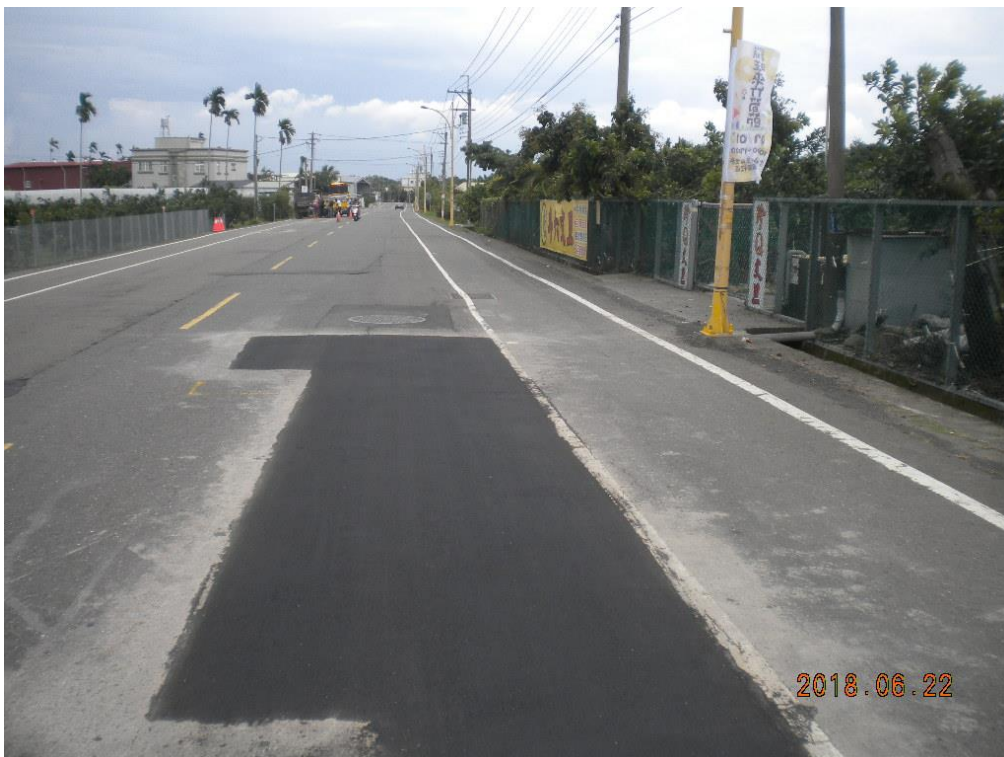
圖 6.4-3 道路破損改善情形(縣 154 乙 14.5K 處)
