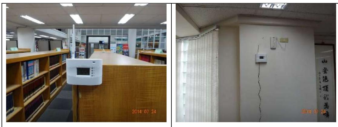
圖4-6.4 二氧化碳連續監測儀器安裝情形
