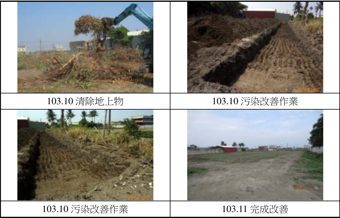
圖 4.3-15、北港鎮溝皂段 1463、1464 地號場址巡查照片
