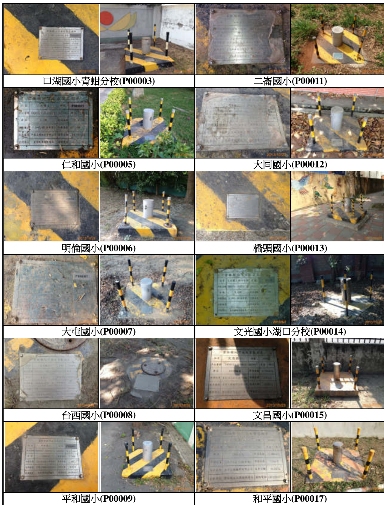
圖 3.1-2、縣內監測井現況(1/2)
