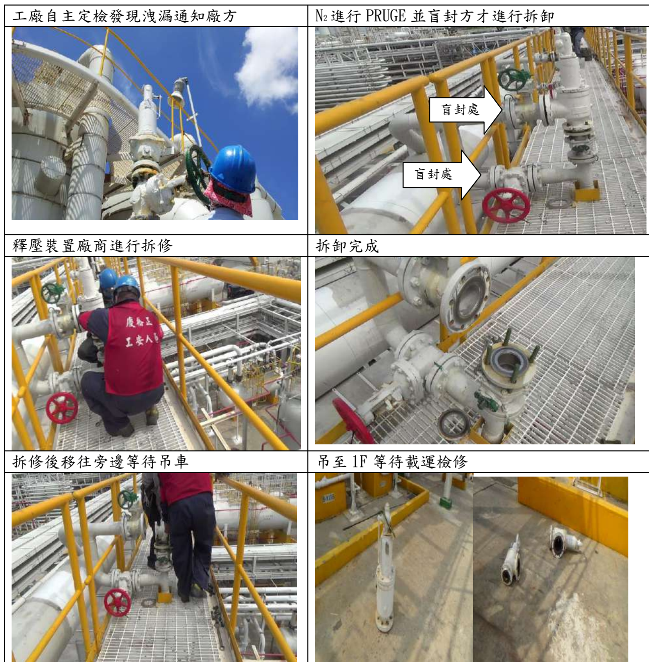
圖 6.3-4、釋壓裝置發現洩漏檢修流程
