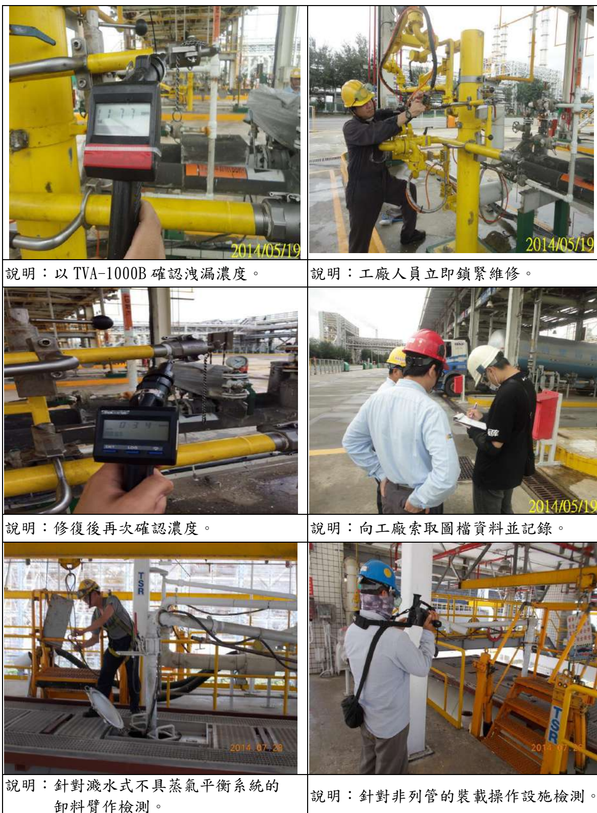
圖 5.3-1、裝載操作設施紅外線氣體成像儀篩檢工作方法(2/2)
