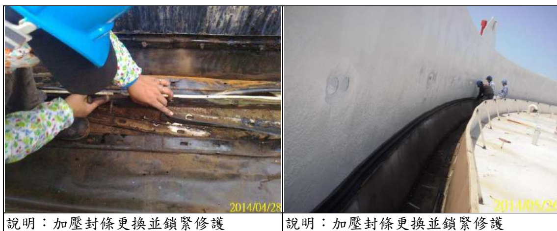
圖 4.2.5-4、輕油廠加壓封條維修情形
