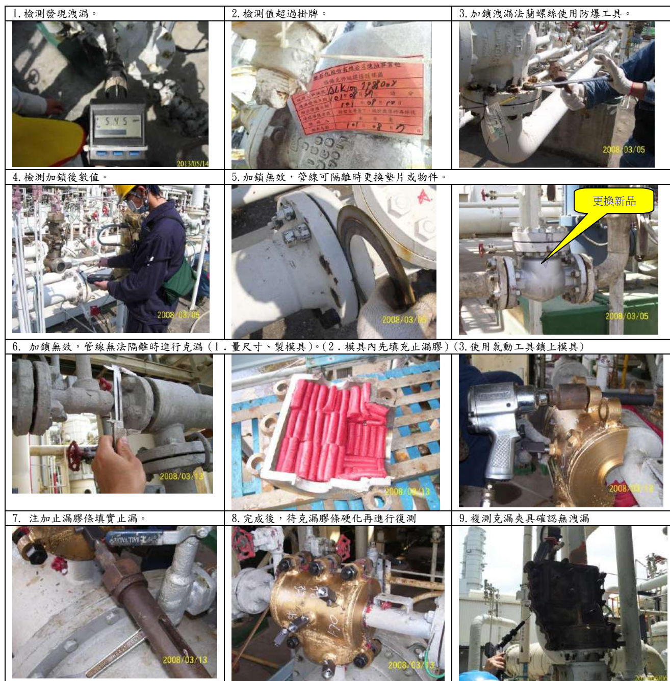
圖 6.4-6、法蘭洩漏處維修機制
