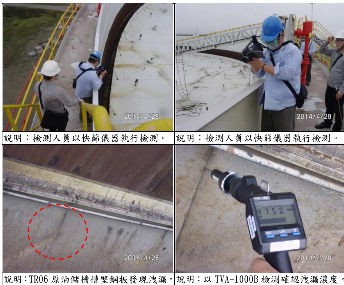
圖 4.2.5-3、外浮頂槽封氣設備洩漏檢測
