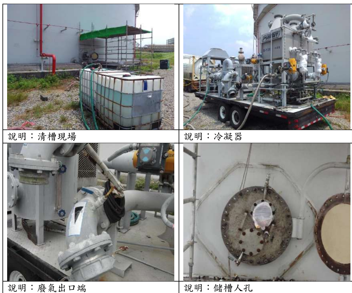
圖 4.3-2、清槽過程現勘
