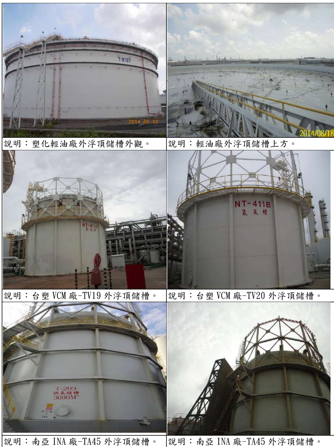
圖 4.2.5-1、各廠外浮頂槽現況
