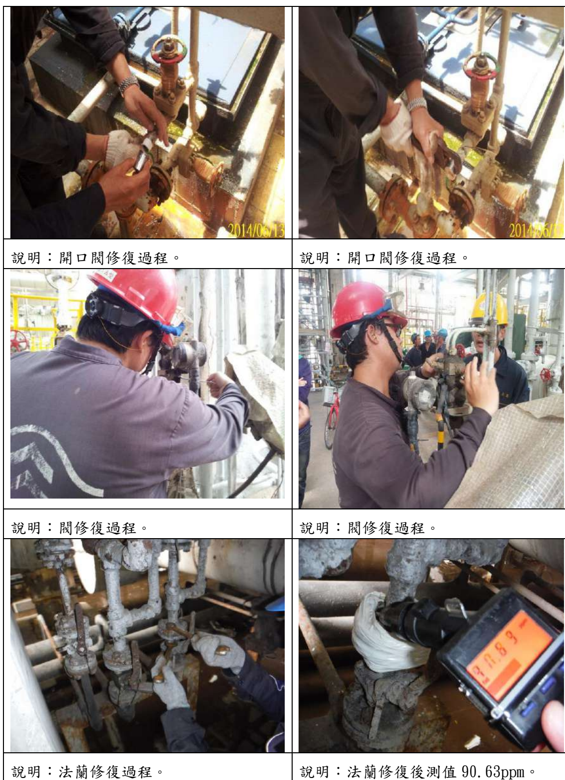
圖 6.6-9、設備元件洩漏維修過程
