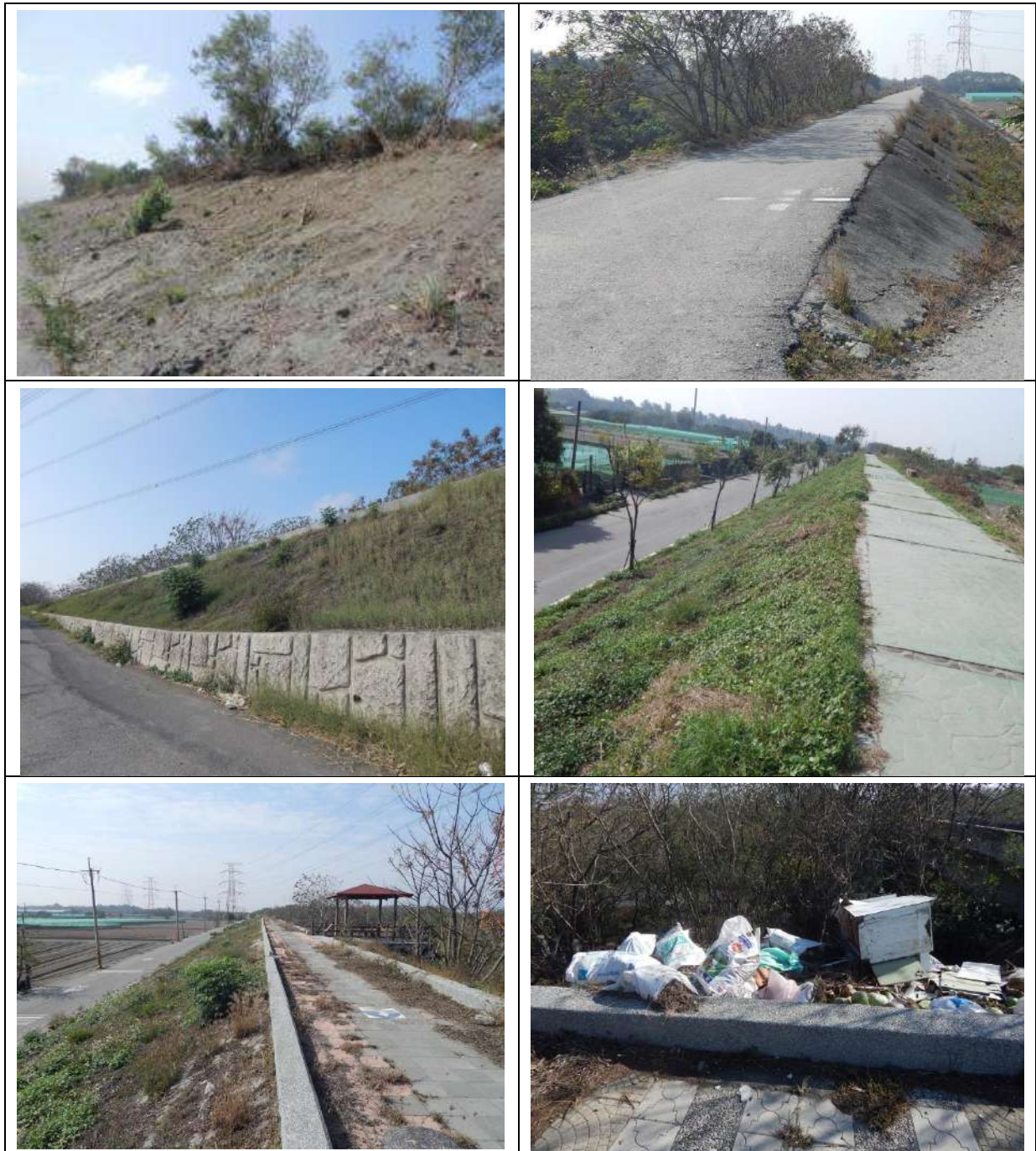
圖4.1-4 南岸堤防邊坡綠化狀況
