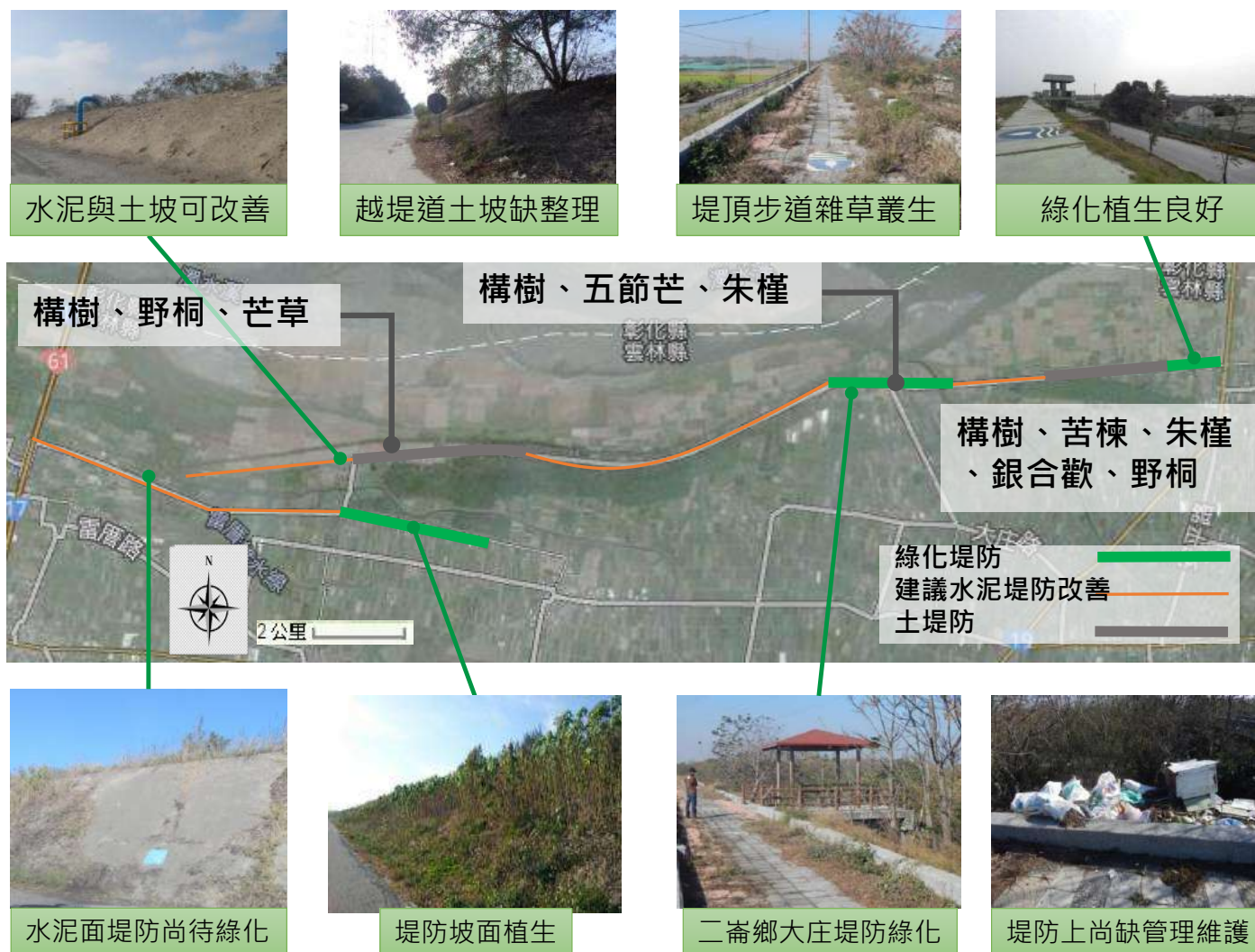
圖4.1-2 南岸堤防現況圖
