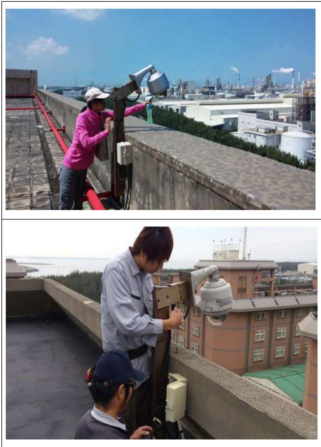
圖 5.4-9 CCTV 每月現場維護照片
