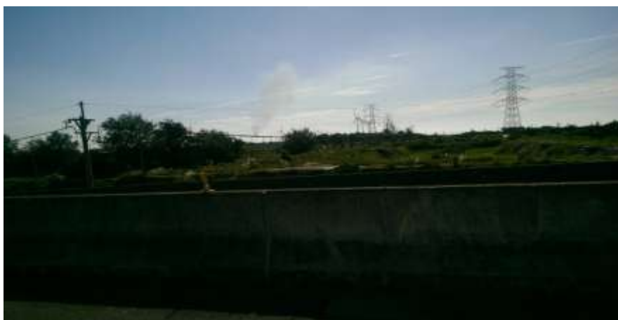
圖 4.1.2-8、103.7.3 塑化輕油廠煉三廠燃燒塔異常排放照片
