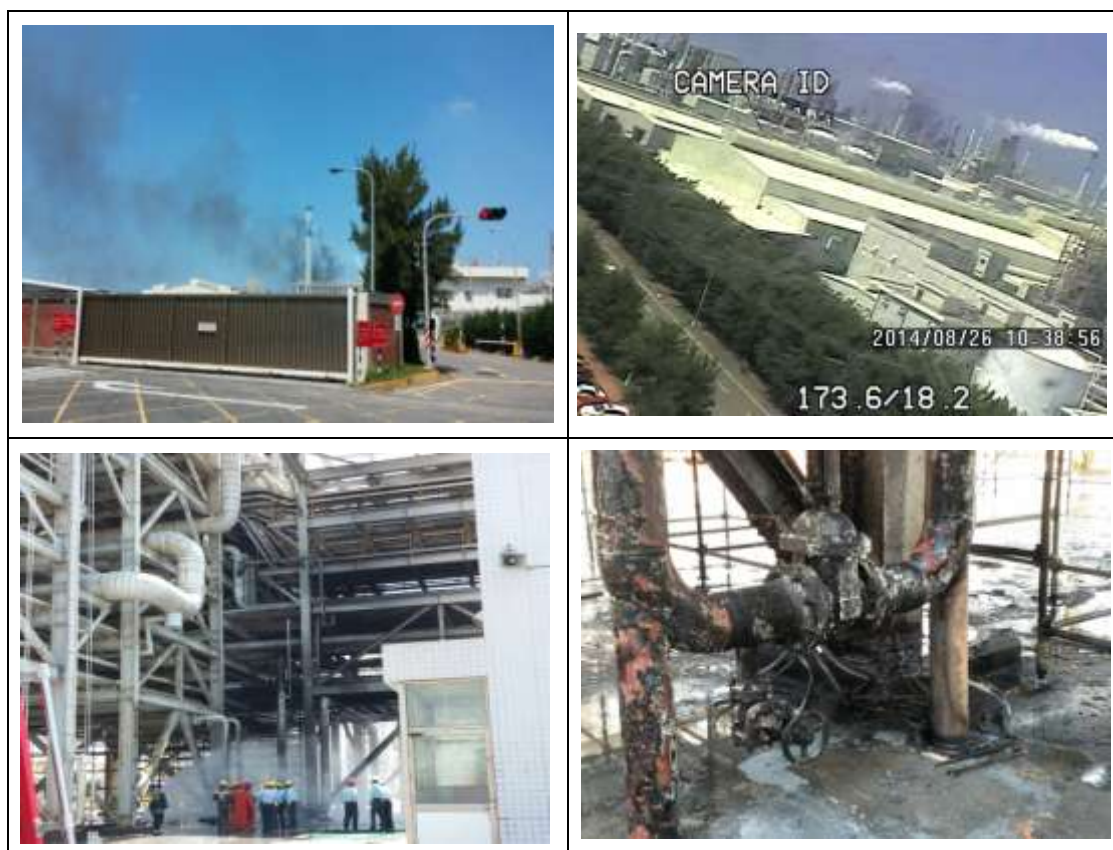
圖 4.1.2-3、公用管線火災現場
