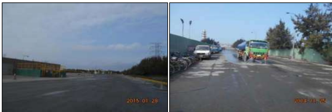
圖4.1-27 加強工區外加強灑水頻率與道路認養作業
