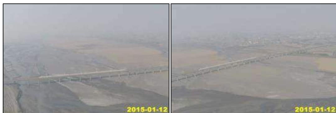
圖3.2-17 西螺鎮高鐵行經處橋(南岸) 左側與右側空拍情形
