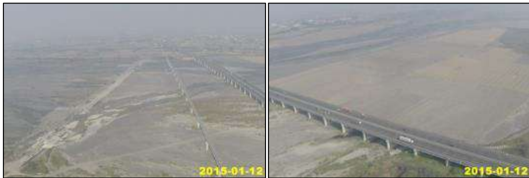
圖3.2-16 國道 1 號中沙大橋(南岸)左側與右側空拍情形
