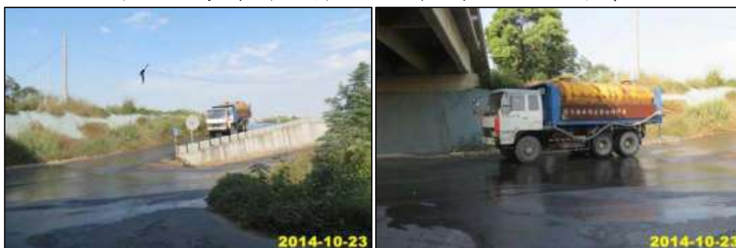
圖8.2-16 麥寮鄉西濱大橋北岸-攔水土堤施作情形
