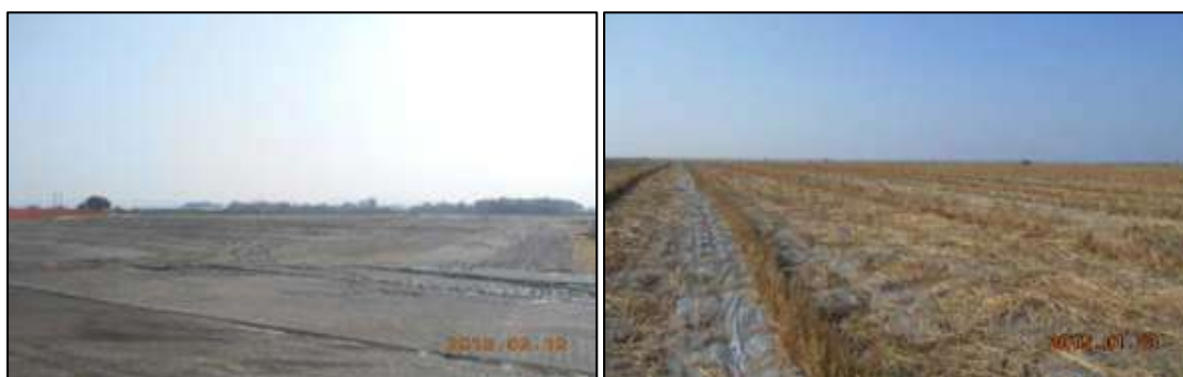
圖4.1-28 營建工地之大面積裸露地鋪設防塵網及稻草蓆防護
