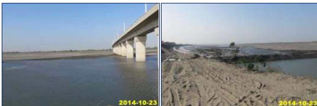
圖8.3-26 第一次濁水溪裸露灘地機具灑水示範區現勘(西螺鎮)
