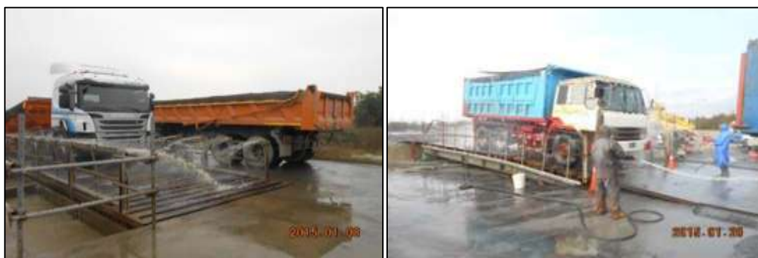
圖4.1-26 加強砂石車輛防塵網覆蓋下拉 15 公分與車輛輪胎沖洗
