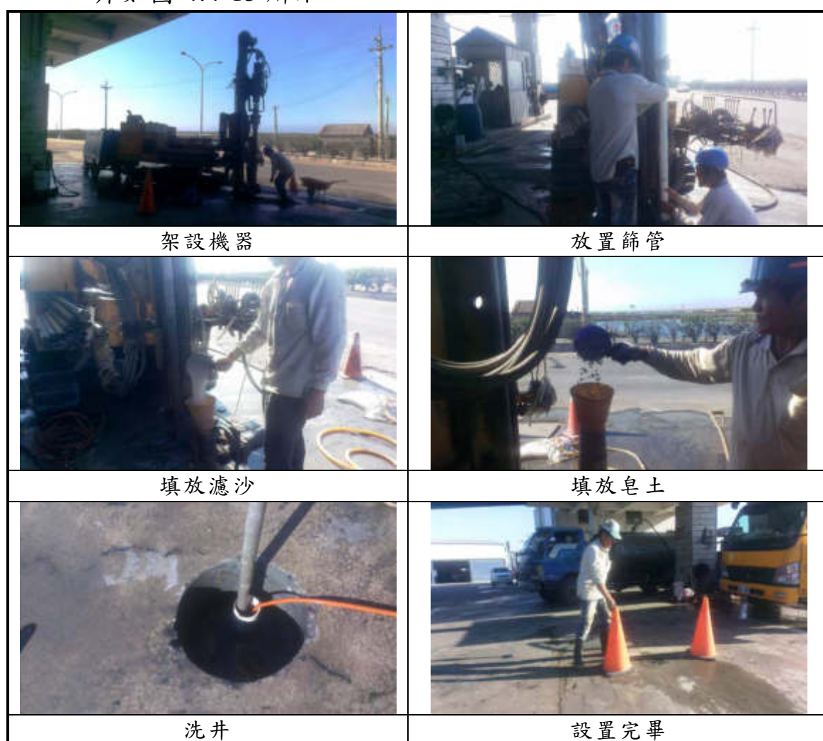
圖 4.4-13、全民加油站地下水監測井設置照片
