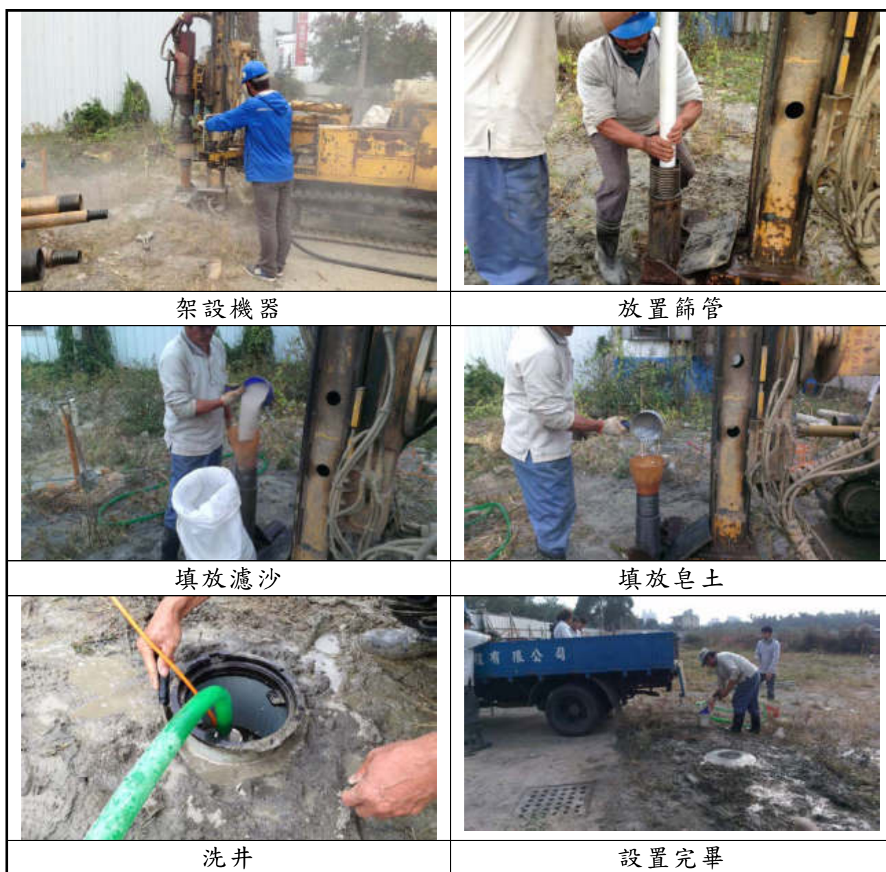
圖 4.4-19、新南環加油站地下水監測井設置照片
