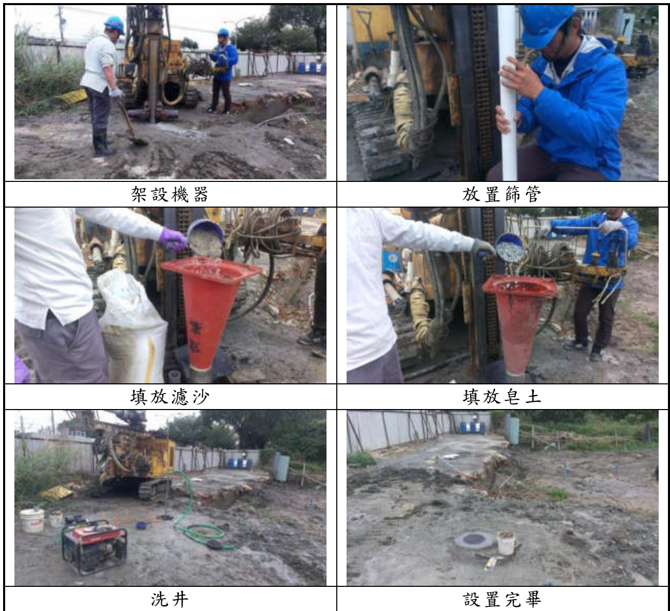
圖 4.4-25、大學加油站地下水監測井設置照片
