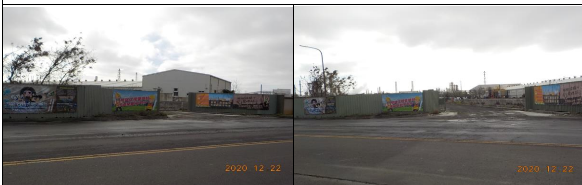
鴻捷營造有限公司所屬的麥寮資源回收處新設焚化爐土建工程
