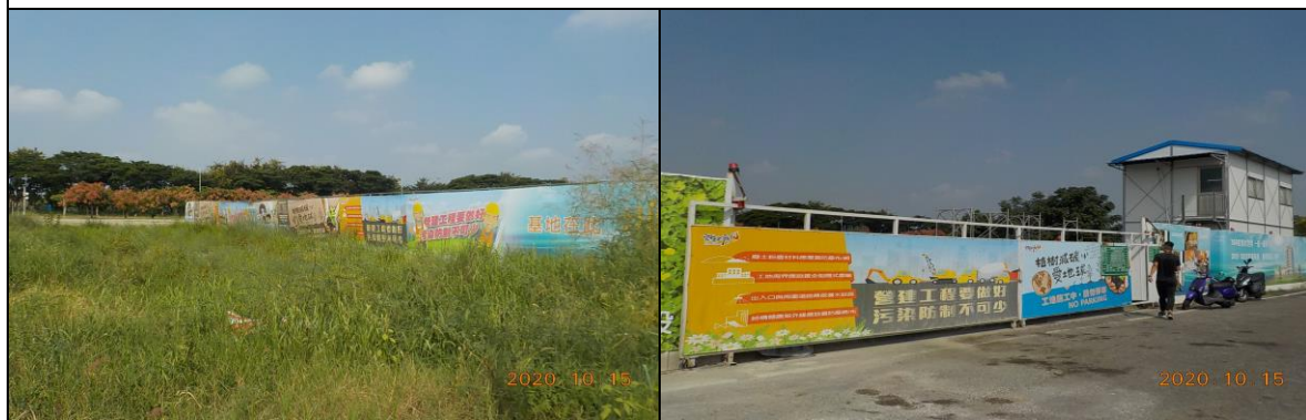
欣祥營造股份有限公司所屬的兆曜欣業建設-店鋪、集合住宅新建工程
