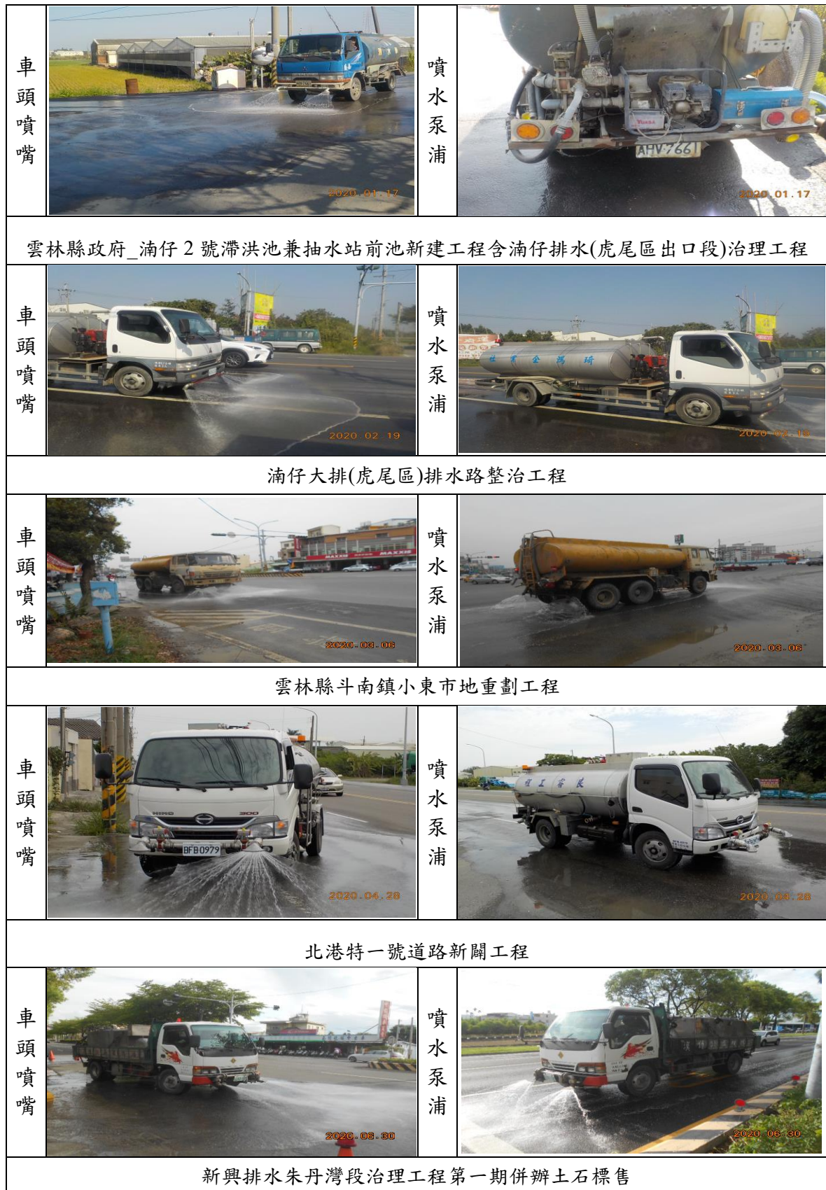
圖 6.3-2 工地洗街車符合環保署洗街車作業規範照片
