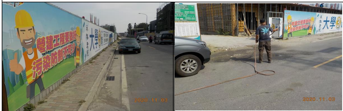
廣裕營造工程有限公司所屬的禾楓君悅大學段 34 戶住宅新建
