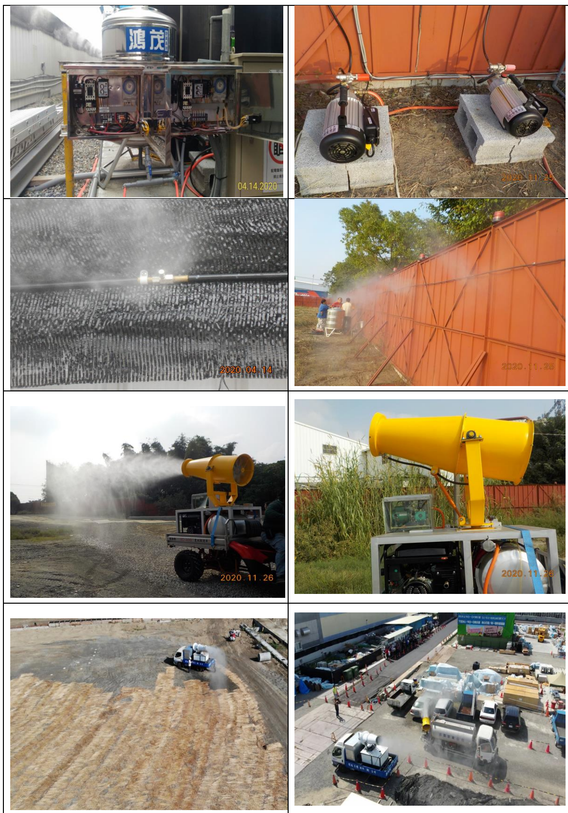
圖 5.4-1 霧炮機+物聯網自動灑水設施設備及成果照片
