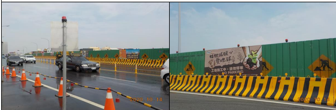
頤達營造股份有限公司所屬的台 1 線石牛溪橋改善工程
